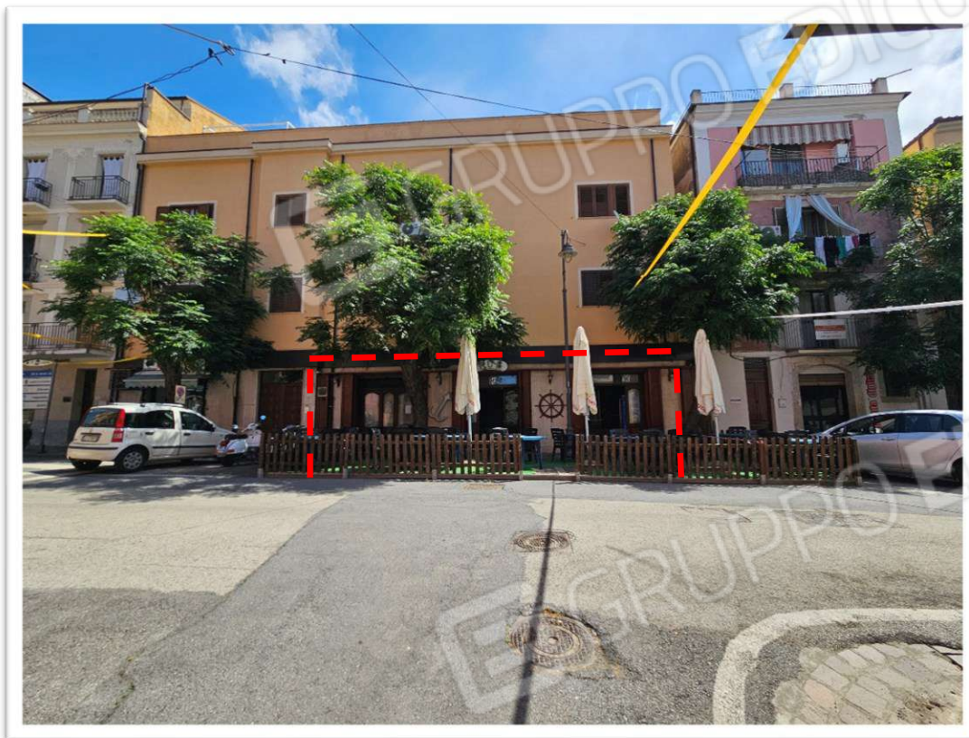
Foto 19 – Prospetto Ovest - Indicazione immobile - - -
