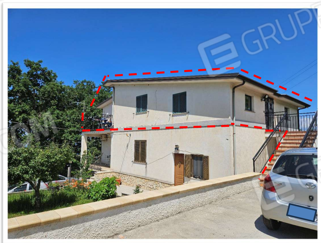
Foto 2 - Vista prospetto Sud/Est - Indicazione immobile - - -
