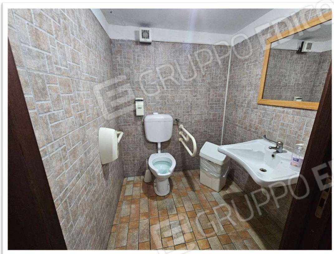
Foto 27 – Servizio igienico disabili
