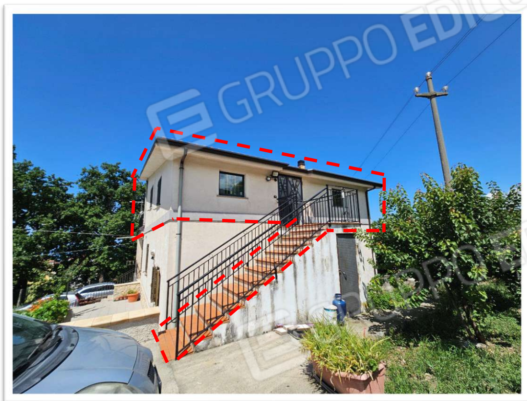
Foto 1 - Vista prospetto Sud/Est - Indicazione immobile - - -
