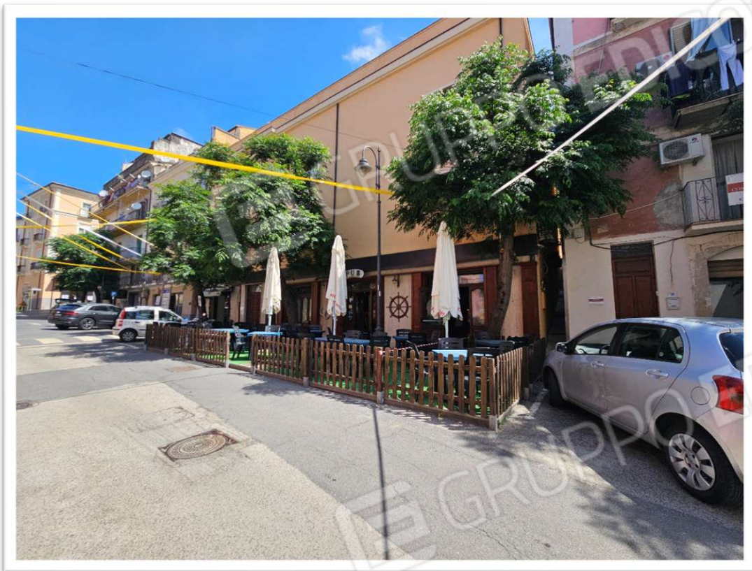
Foto 21 – Vista da Sud del Prospetto Ovest
