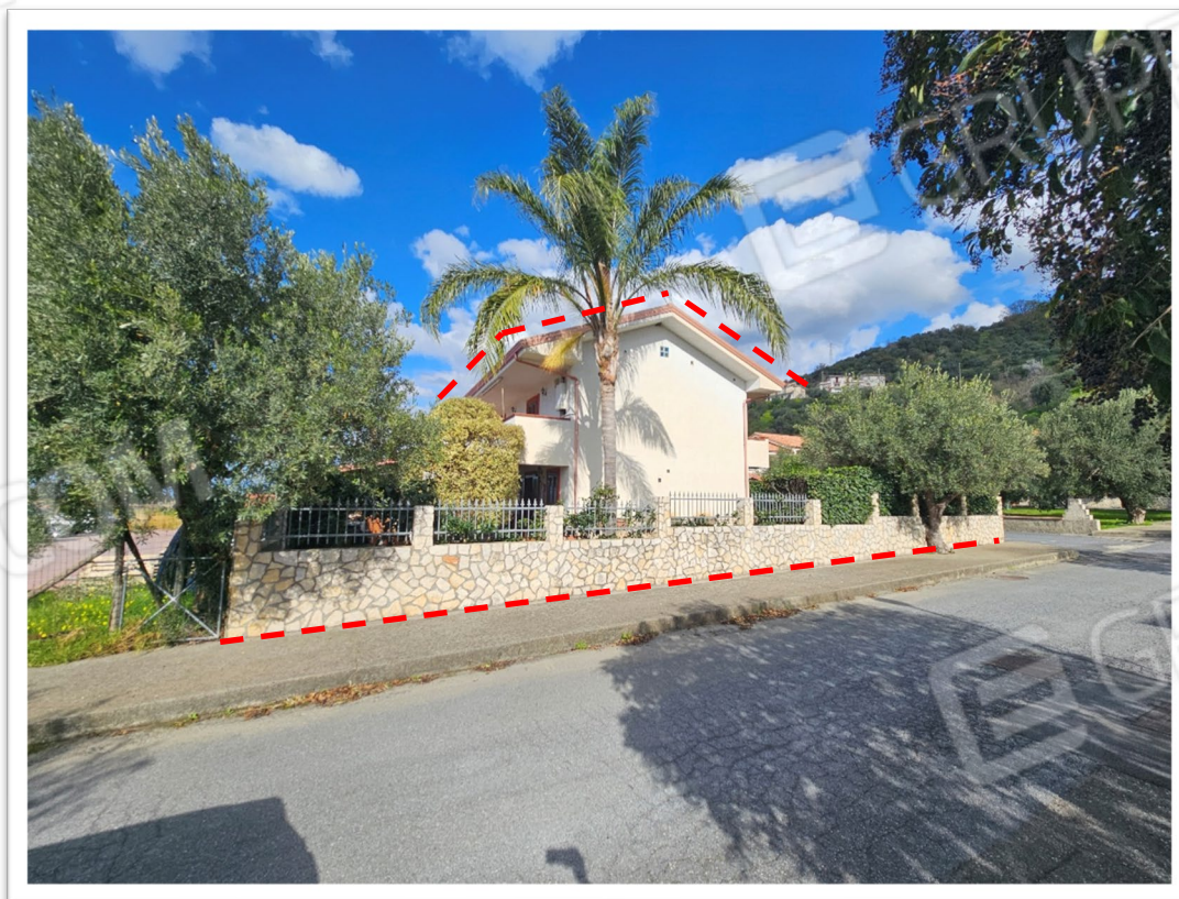
Foto 2 - Vista prospetto Sud/Ovest - Indicazione immobile - - - -
