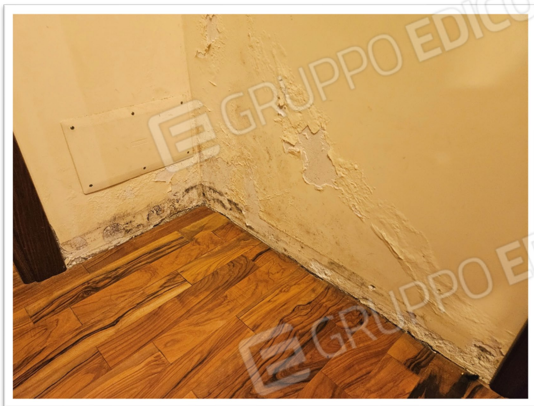
Foto 27 – Particolare umidità da presunta perdita impianto idrico bagno comune piano primo
