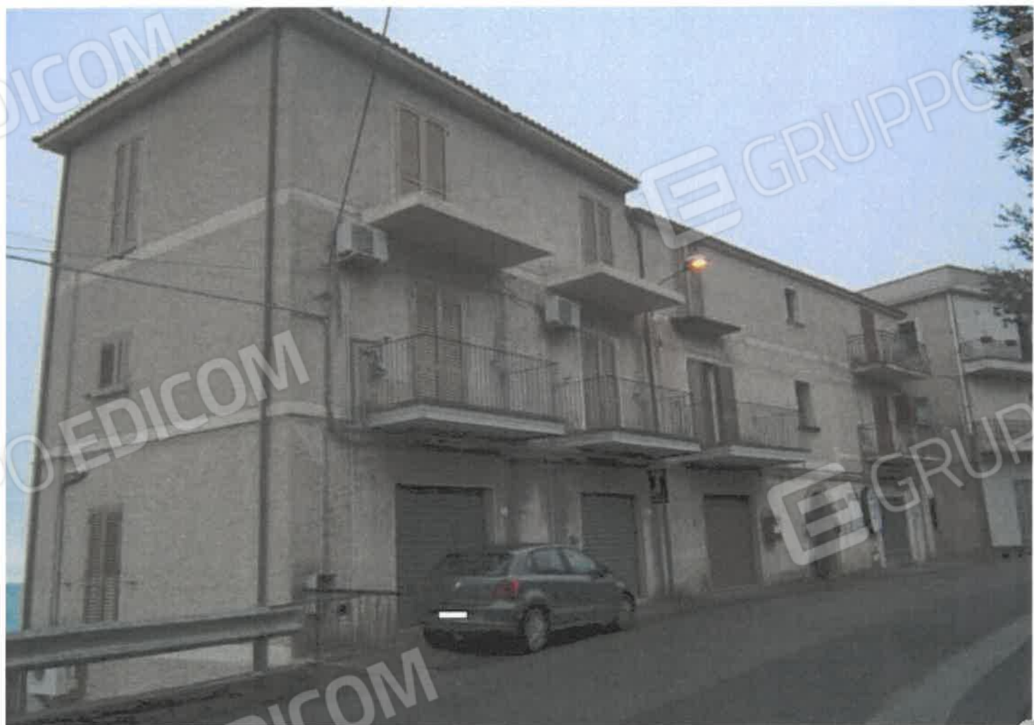
FOTO PROSPETTO SUD-EST DEL FABBRICATO
