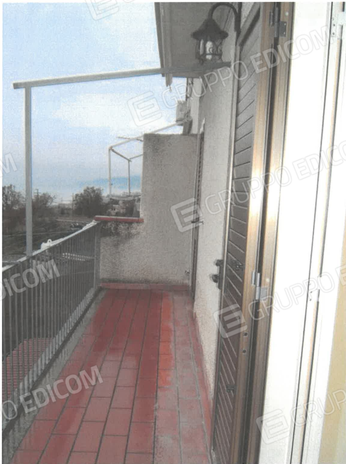
FOTO TERRAZZO LATO OVEST
