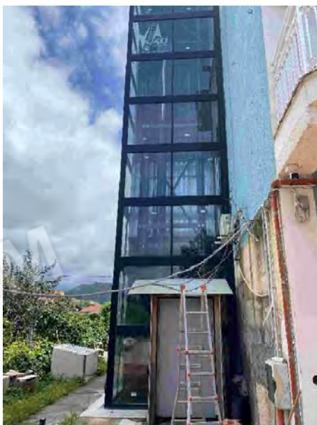
Struttura Alberghiera D/2- Fg. 31 P.Ila 233 Sub. 11
