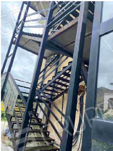
Struttura Alberghiera D/2- Fg. 31 P.Ila 233 Sub. 11
