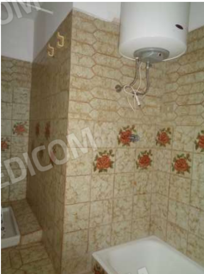
LOCALE BAGNO PIANO 1° FOTO 8
