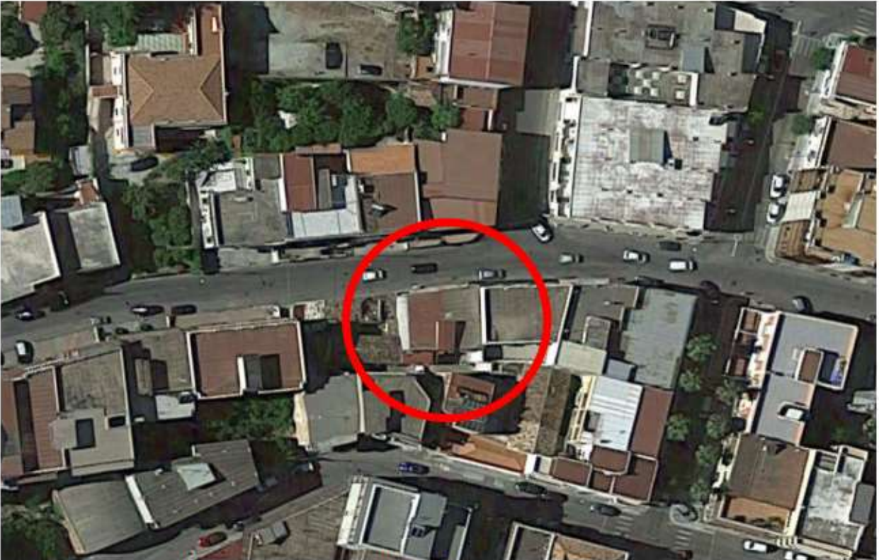
Figura 3 – Foto aerea dell'immobile dove sono ubicati i lotti 1,2,3,4.
