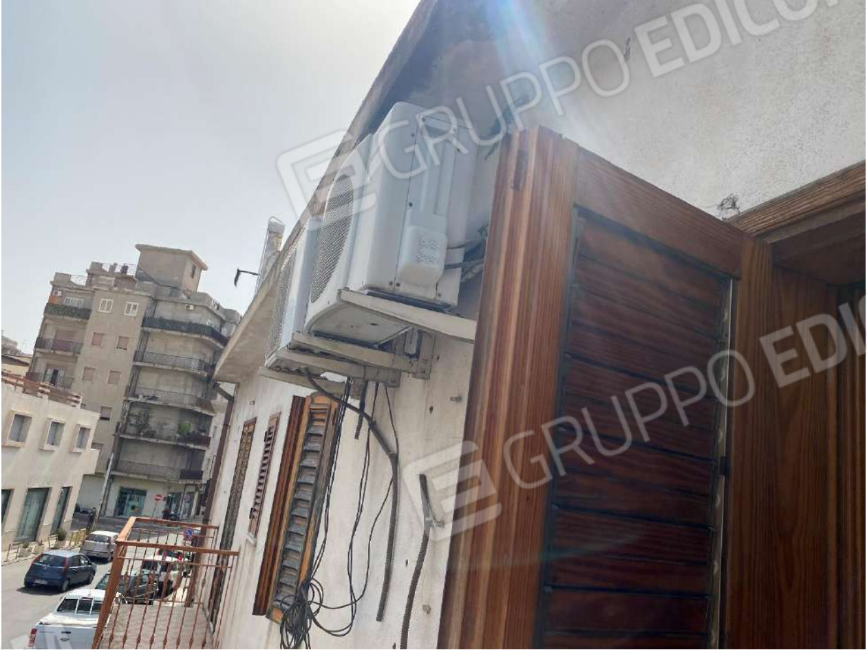
Foto n. 91, n. 92. Esposizione esterna dei cavi. Infissi compromessi. Balconi con mufte e dilavamento
