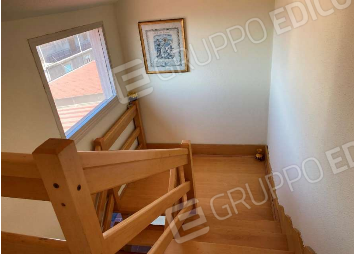
Foto n. 140. Vano scala interno. Dettaglio elementi in legno.
