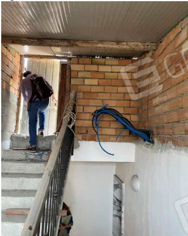
Ingresso al lastrico solare
