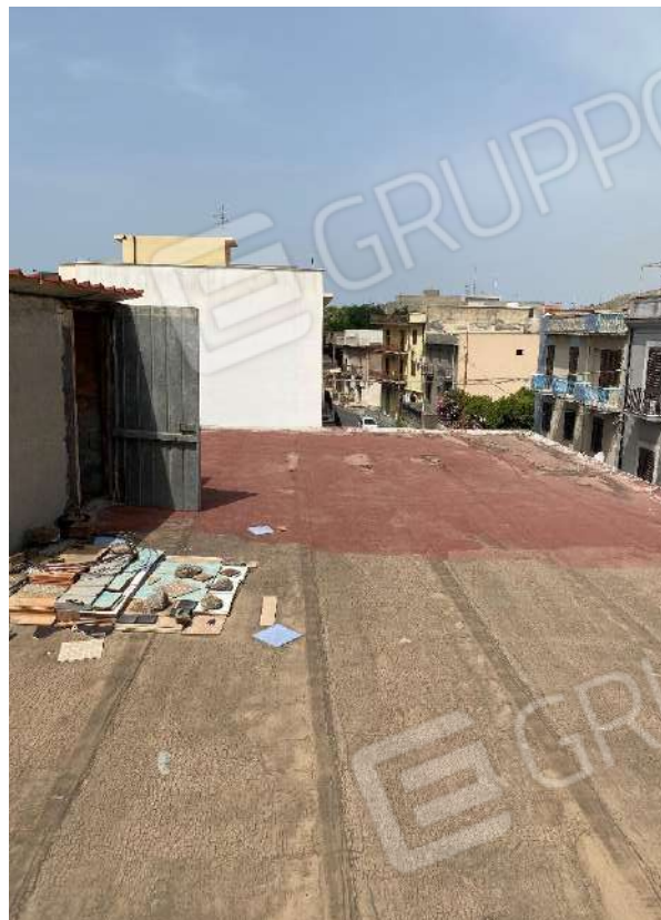
Foto n. 97, n. 98. Lastrico solare. Impermeabilizzazione con fasce di discontinuità ed eterogeneità
