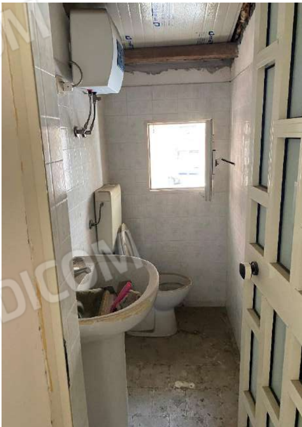
Foto n.18, n.19. Bagno. Porta in alluminio e copertura inclinata non rifinita
