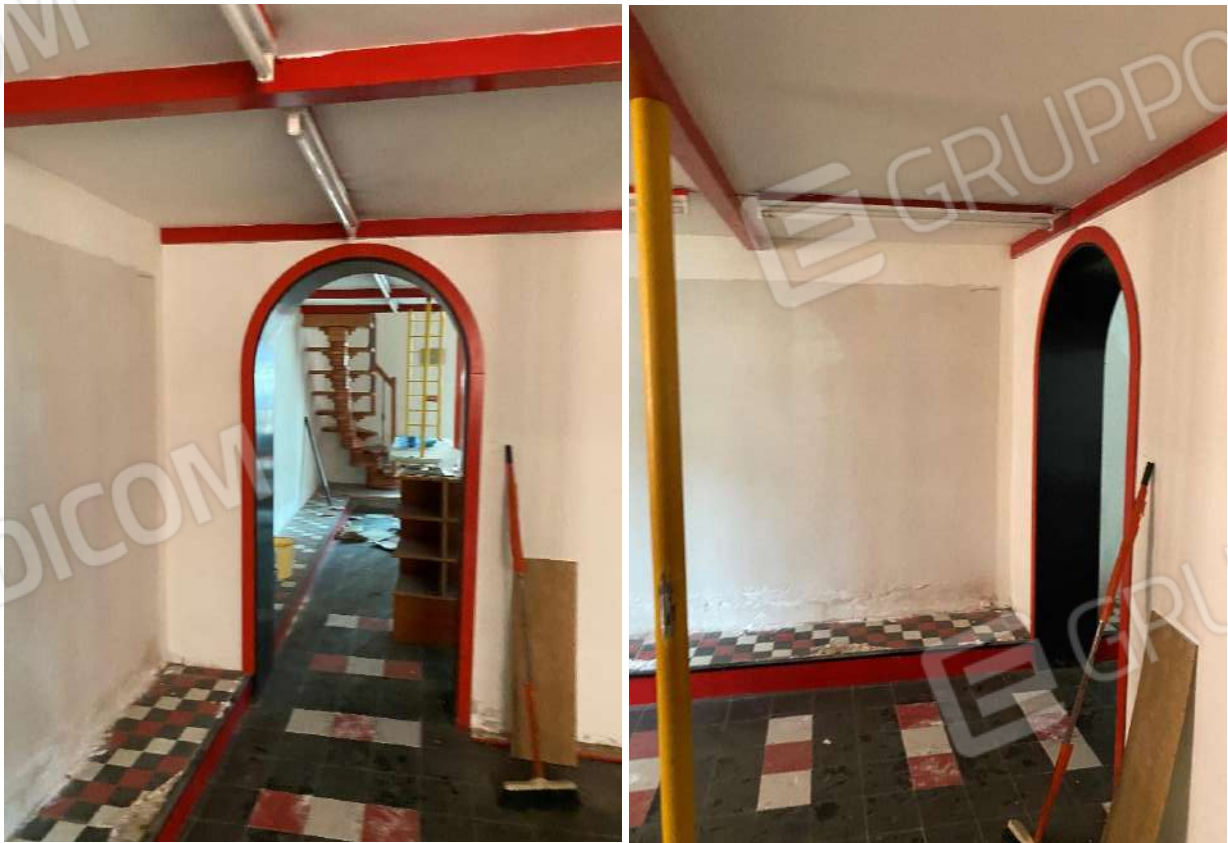
Foto n. 10, n. 11. L'altezza del piano risente della presenza del soppalco. La pavimentazione è ribassata.
