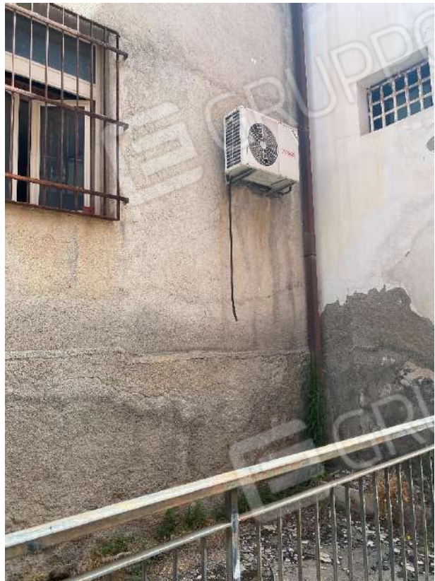
Foto n. 22, n.23. Finiture mancanti e deteriorate. Parziali crolli d'intonaco e diversi stadi d'infiltrazione
