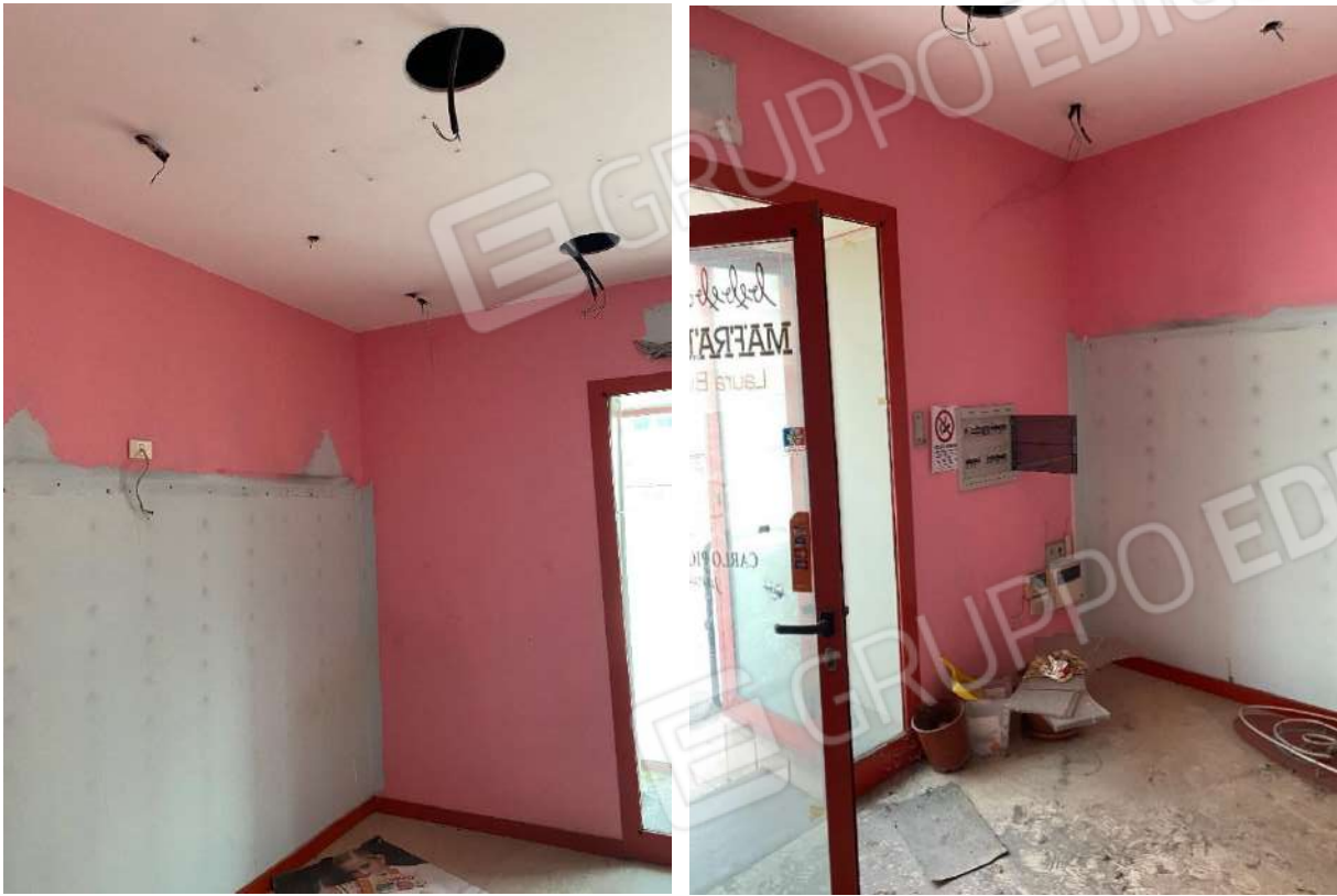
Foto n. 38 , n. 39. Controsoffittature con alloggiamento sistema elettrico
