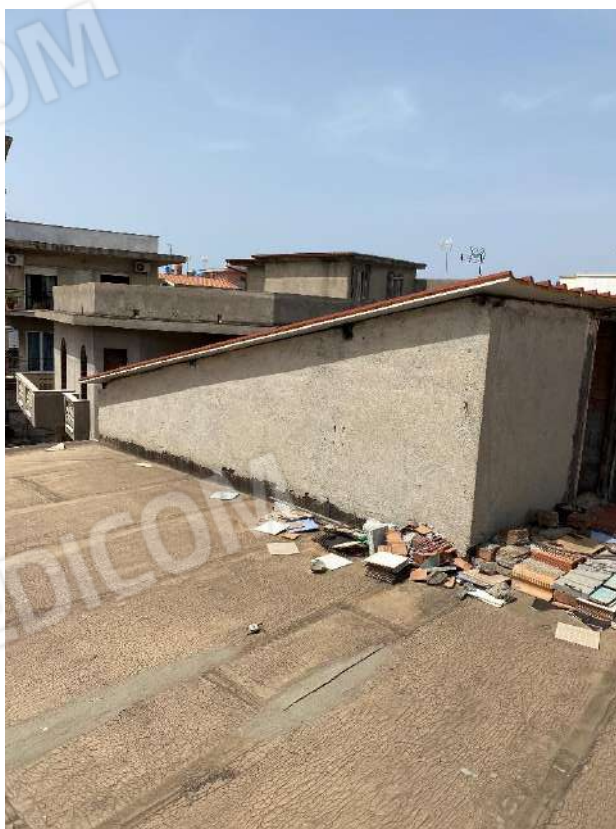
Foto n. 97, n. 98. Lastrico solare. Impermeabilizzazione con fasce di discontinuità ed eterogeneità
