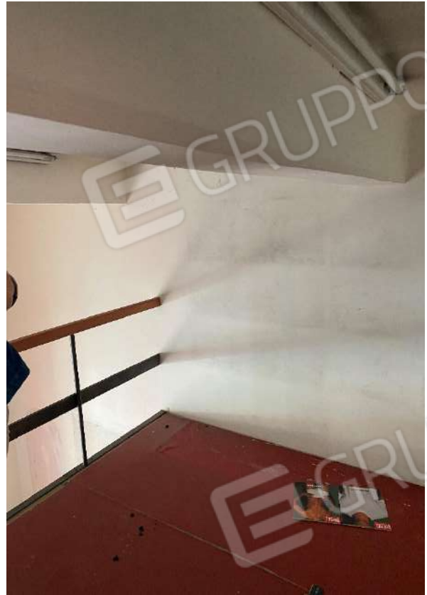
Foto n. 25, n. 26. Altezza di piano, 1,75 m, non a norma (Art. 36 del Regolamento Edilizio, altezza >2.20)
