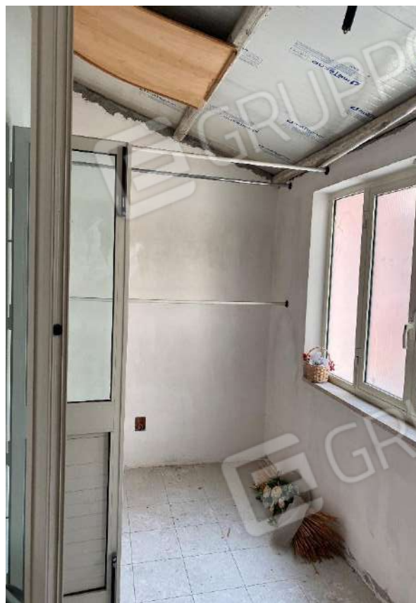
Foto n. 44, n. 45. Terzo ambiente. Infissi in alluminio, copertura inclinata non ultimata.
