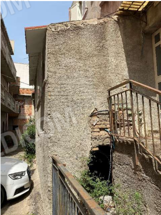
Foto n. 22, n.23. Finiture mancanti e deteriorate. Parziali crolli d'intonaco e diversi stadi d'infiltrazione
