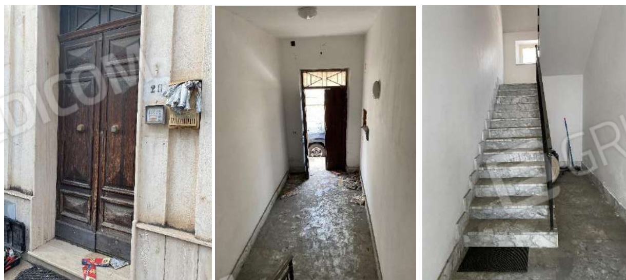
Foto n. 70, n. 71, n. 72. Portone. Vista su strada e su androne interno. Rampa accesso al piano primo
