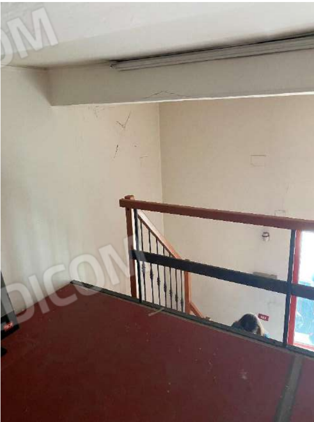
Foto n. 25, n. 26. Altezza di piano, 1,75 m, non a norma (Art. 36 del Regolamento Edilizio, altezza >2.20)
