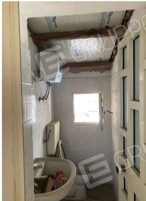
Foto n.18, n.19. Bagno. Porta in alluminio e copertura inclinata non rifinita
