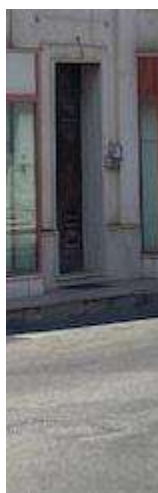
Foto n.3 – Ingresso ai lotti 3 e 4
