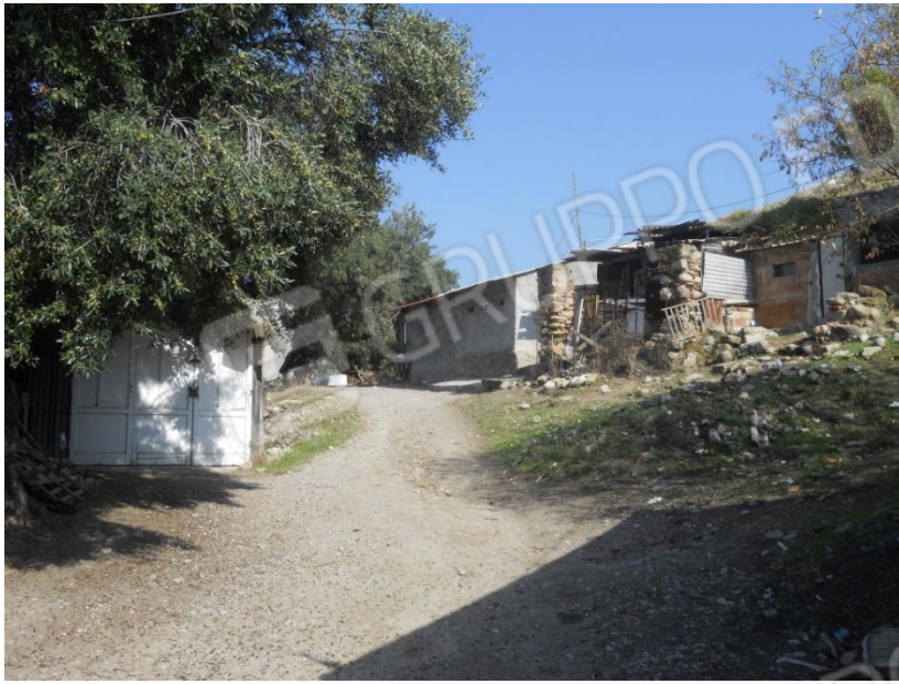
Manufatti insistenti sulla p.lla 137 (oggetto di usucapione)
