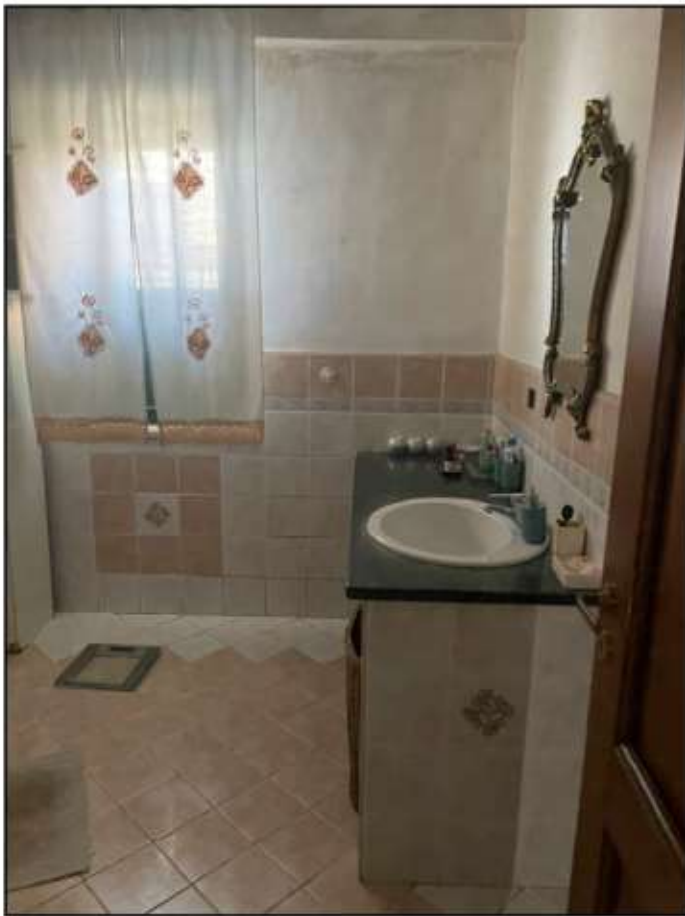
Foto 17 – ripresa del bagno del fabbricato sito in località Nasiti – sub 1
