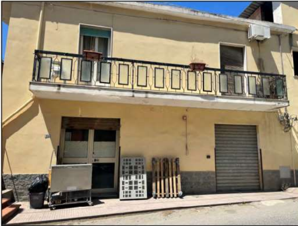
Foto 1 – ripresa del prospetto principale del maggio fabbricato sito in via San Cristofaro (RC)
