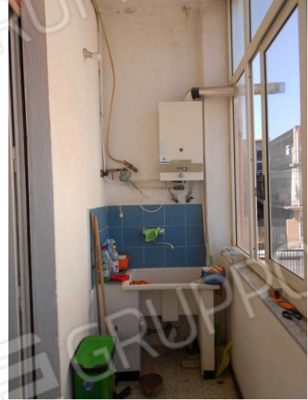
Foto 30 (B- veranda su balcone 2)
