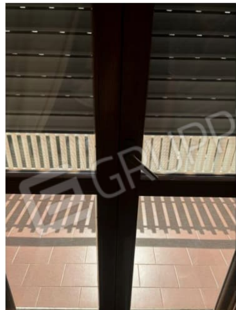
Foto 22: Particolare infisso esterno
