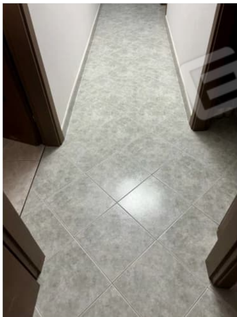
Foto 5: Particolare pavimento corridoio
