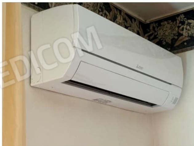
Foto 27: Condizionatore autonomo
