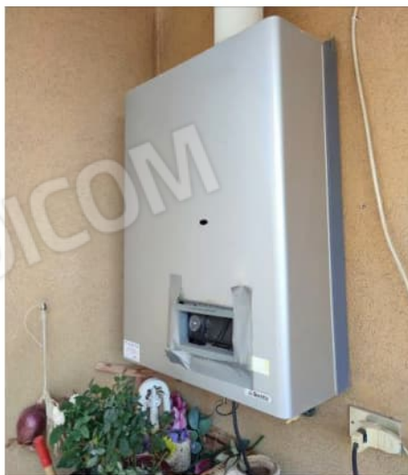
Foto 33: Caldaia autonoma
