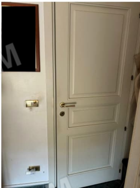
Foto 21: Particolare porta interna
