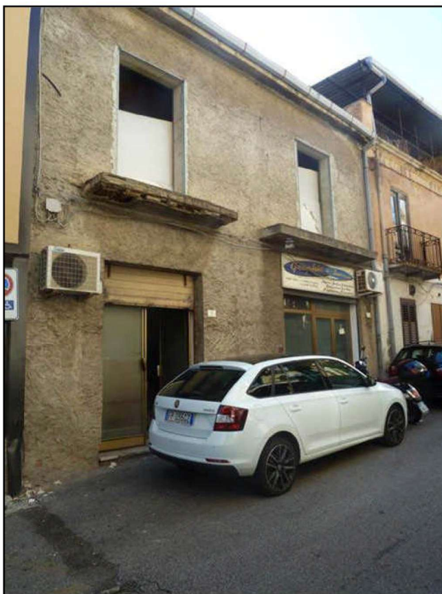
Foto 11 – ripresa del prospetto della particella 1896 , ancora in corso di costruzione, lato via Umberto I°.
