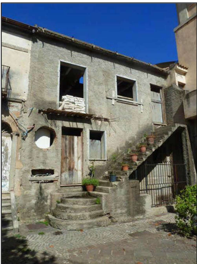
Foto 10 – ripresa dell'ingresso alla particella 1896 , ancora in corso di costruzione, lato via Largo Piano.
