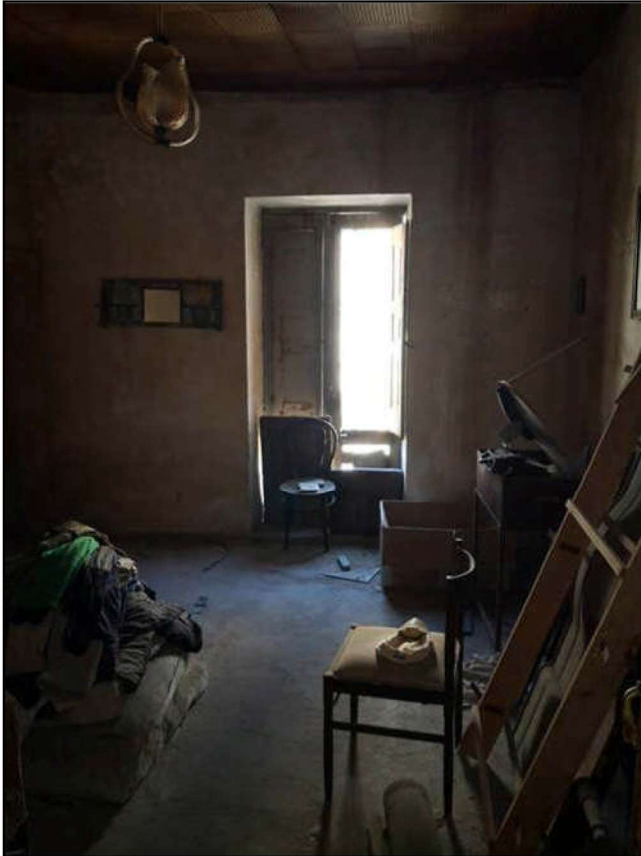
Foto 5 – ripresa di un'altra camera internadelpianoprिमोदellaparti-cella 1064 – Sub 3 .
