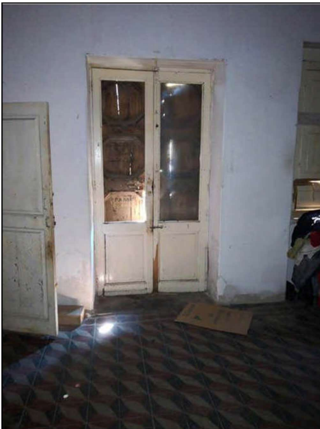
Foto 6 – ripresa di un'altra camera internadelpianoprिमोदellaparti-cella 1064 – Sub 3 .
