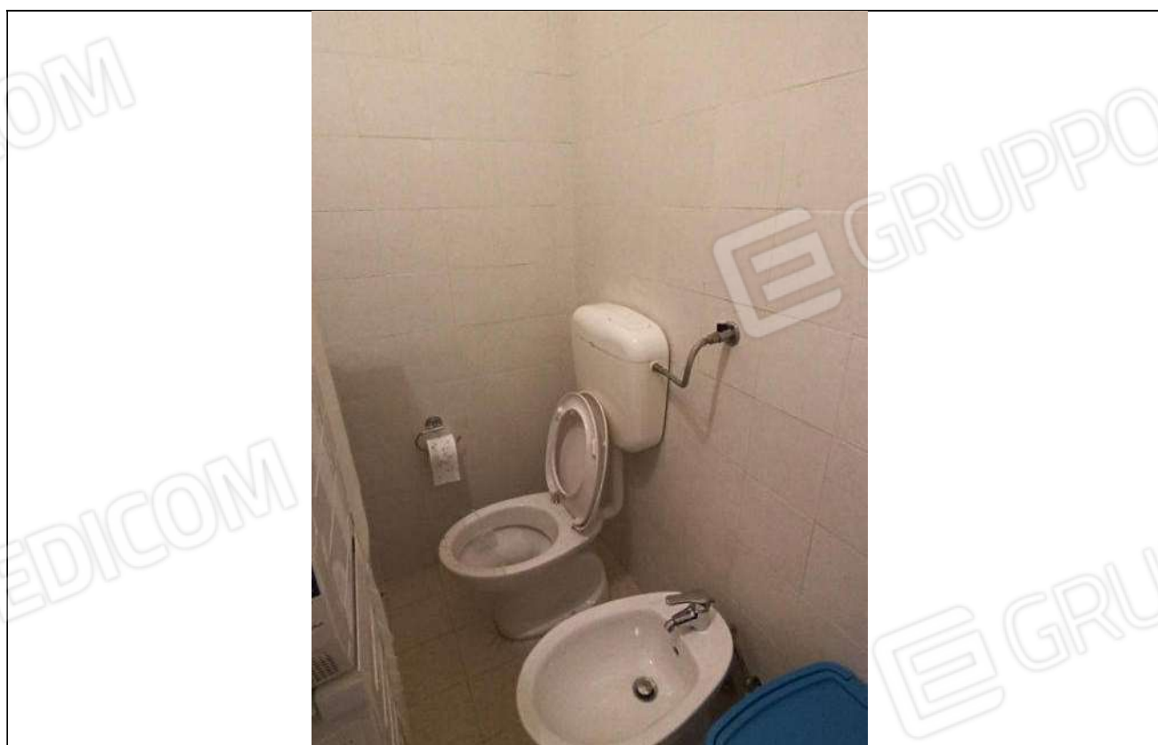
Foto 25. Vista dei sanitari del Bagno
