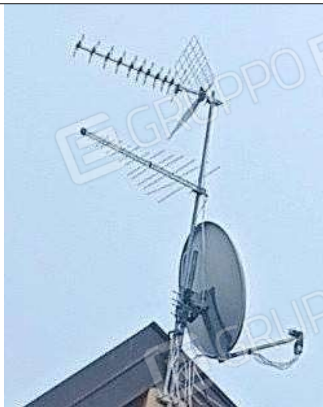
Foto 20. Particolare dell'impianto TV e satellitare
