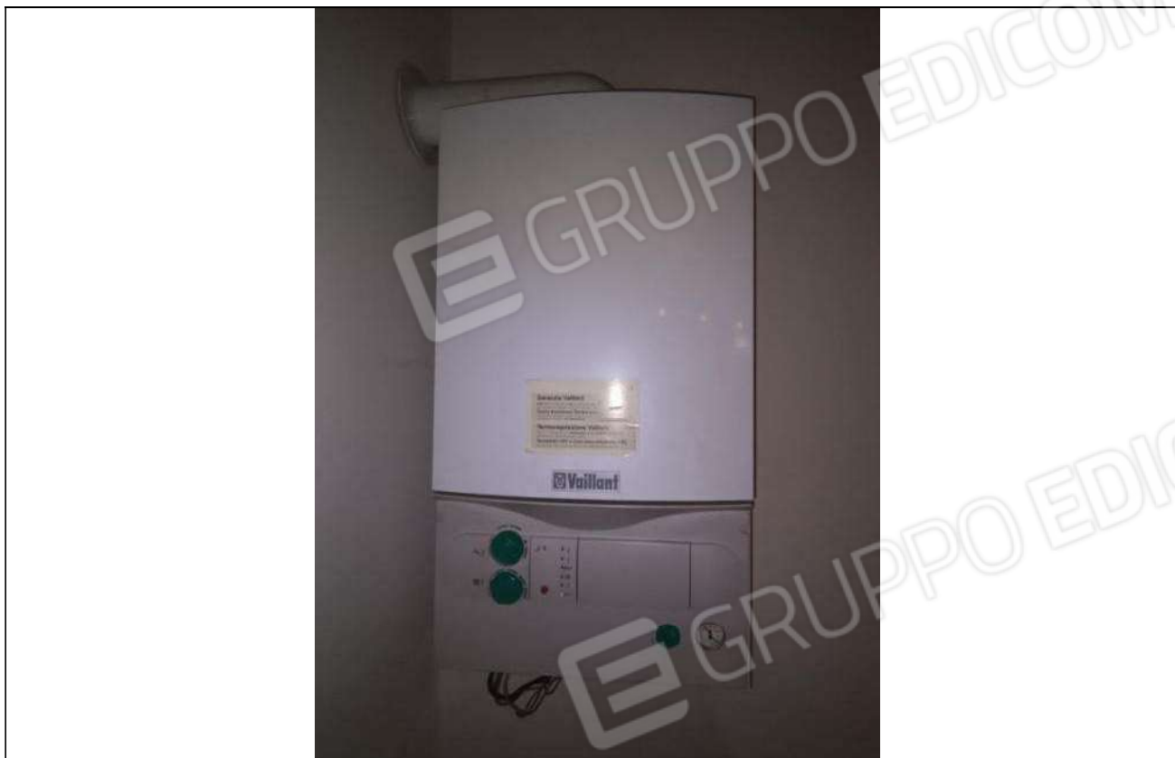
Foto 16. Particolare dello scaldino che gestisce la produzione di acqua calda sanitaria ed il riscaldamento dell'abitazione
