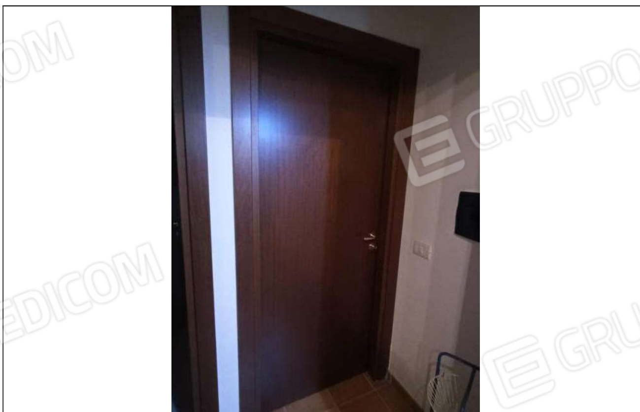
Foto 35. Particolare della tipologia di porta interna, in legno tamburato all'interno dell'abitazione
