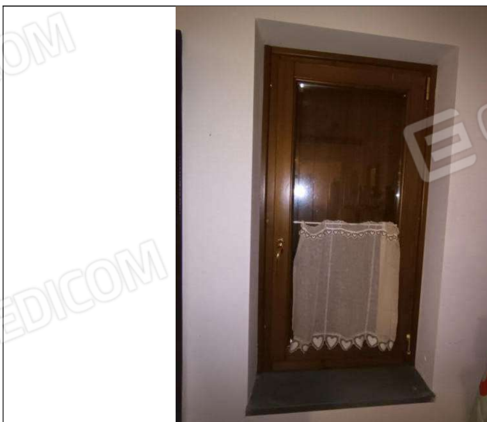
Foto 37. Particolare della tipologia di finestra interna ad una anta, in legno, vetro doppio
