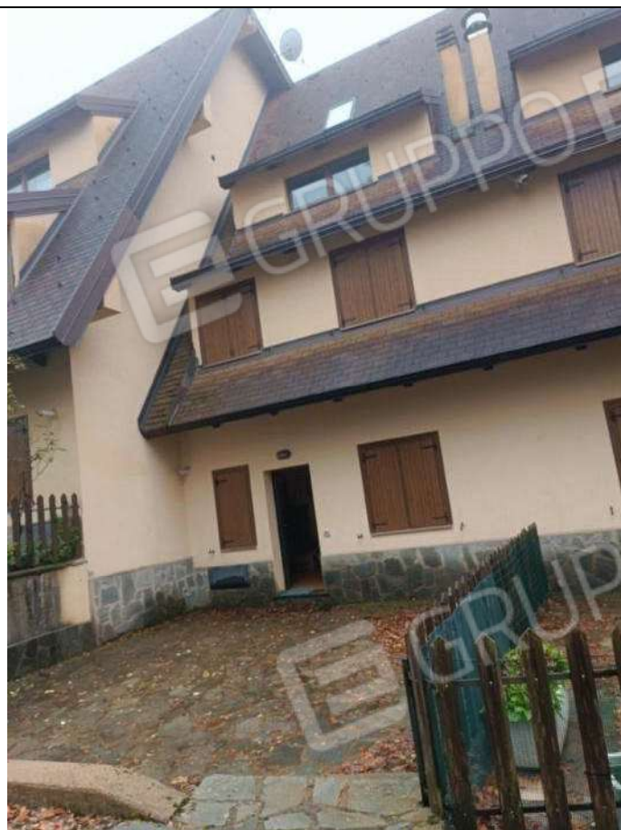
Foto 3. Vista esterna del fabbricato, prospetto principale Nord
