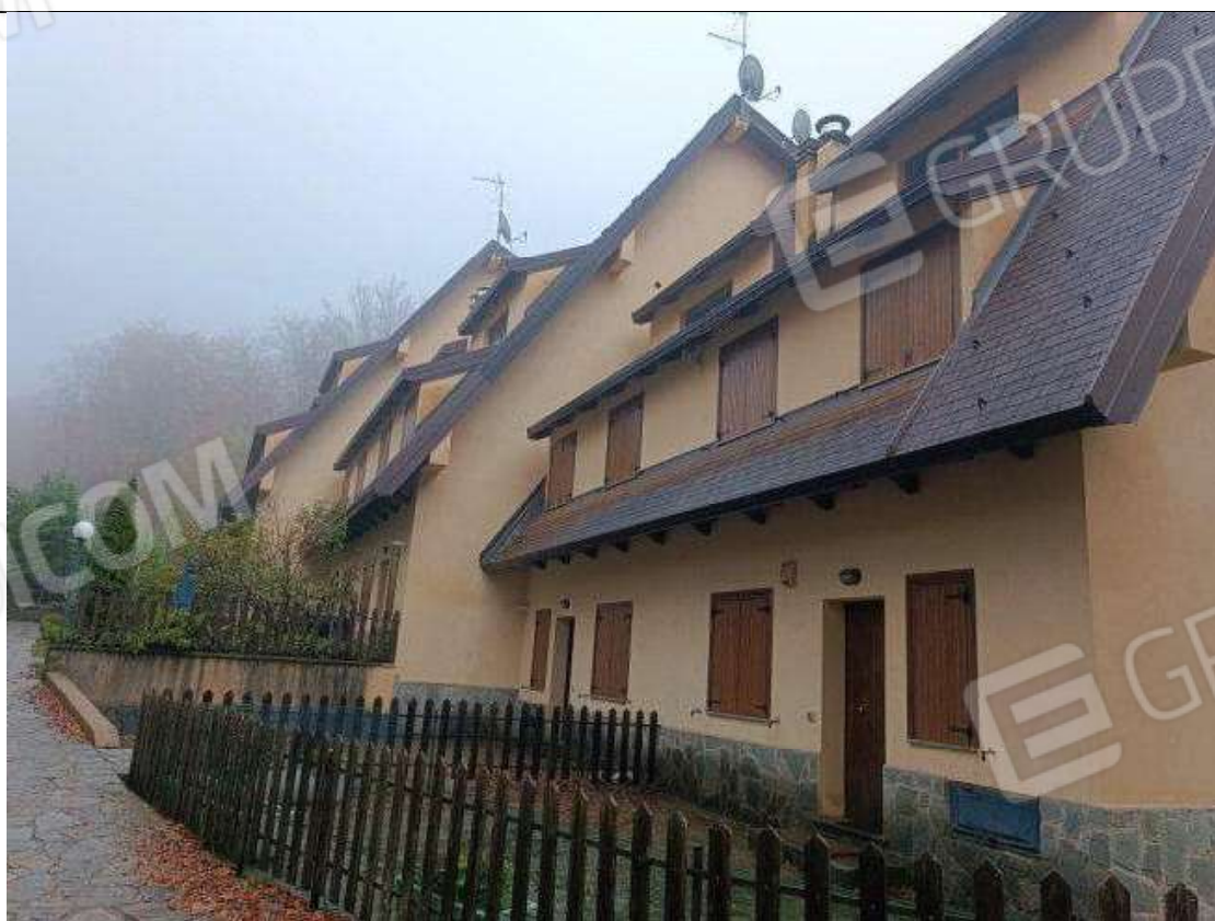
Foto 4. Vista d'insieme esterna dove si scorgono i tre corpi di fabbrica
