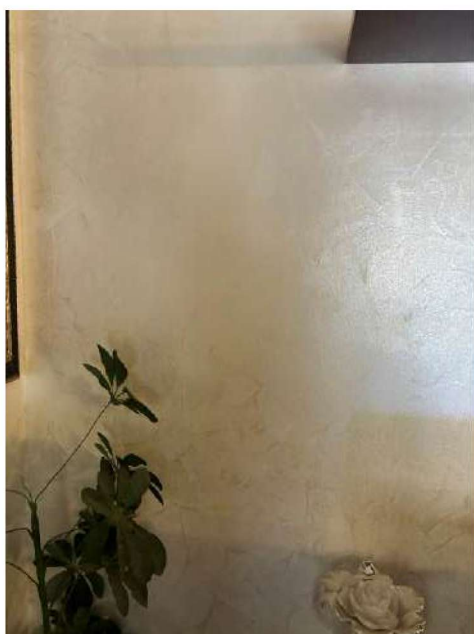
Foto 25: Particolare parete salone
