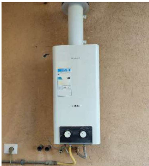
Foto 9: Caldaia autonoma
