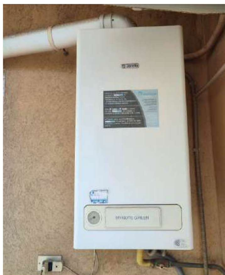
Foto 43: Caldaia autonoma
