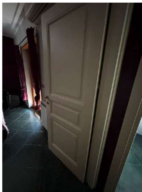
Foto 12: Particolare porta interna
