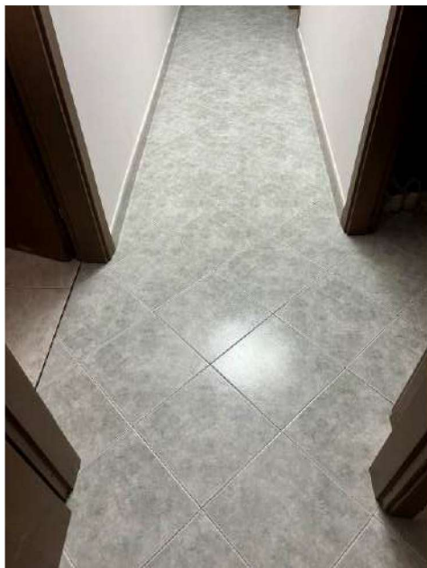
Foto 5: Particolare pavimento corridoio
