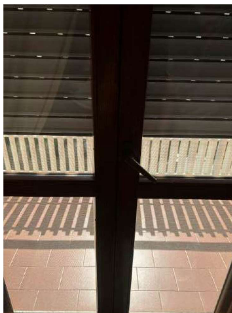
Foto 22: Particolare infisso esterno
