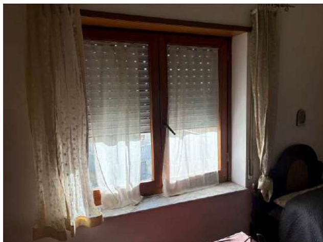
Foto 35: Particolare infisso esterno
