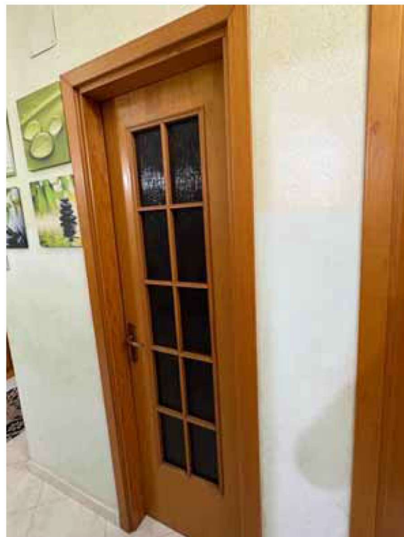
Foto 6: Particolare porta interna
