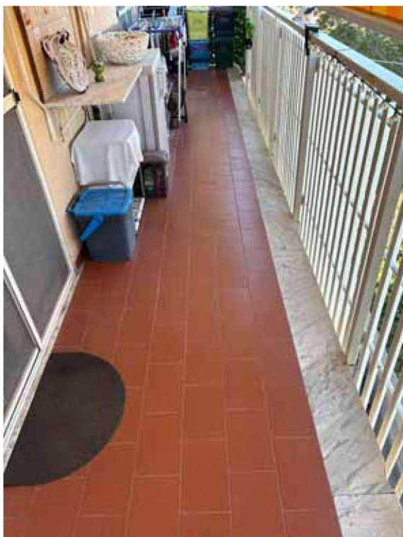
Foto 11: Particolare pavimentazione balcone
