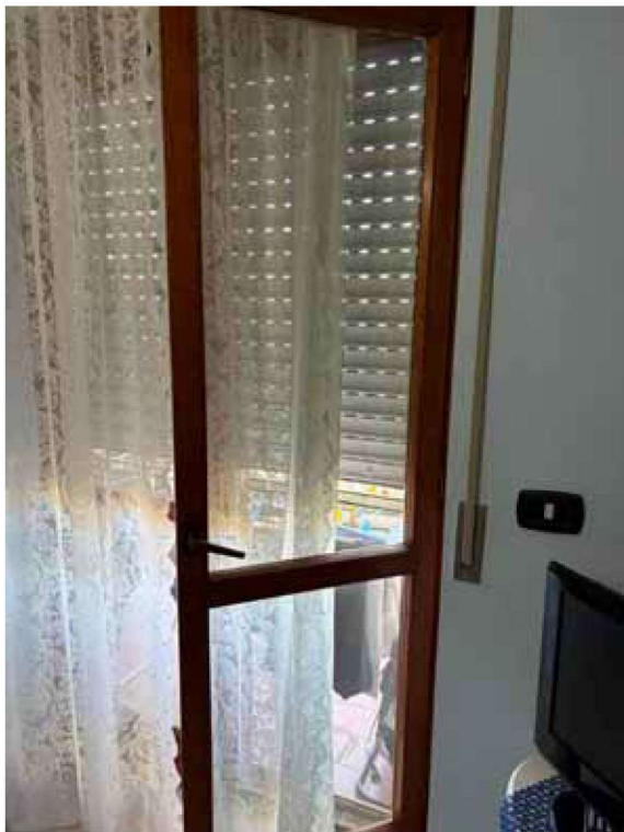
Foto 9: Particolare infisso esterno
