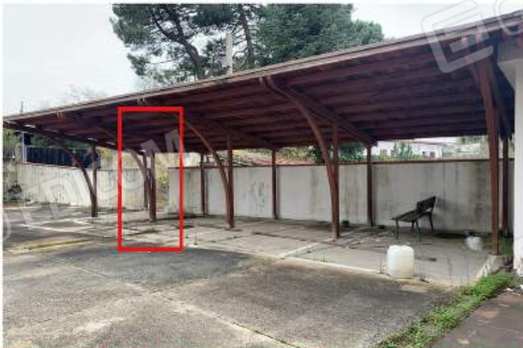
INGRESSO PEDONALE PER ACCEDERE AL PRIMO PIANO SOTTO-STRADA
