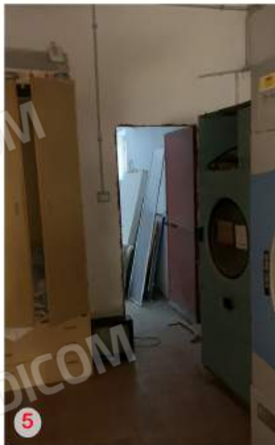
Porta che dal deposito lavanderia da accesso al sottotetto
