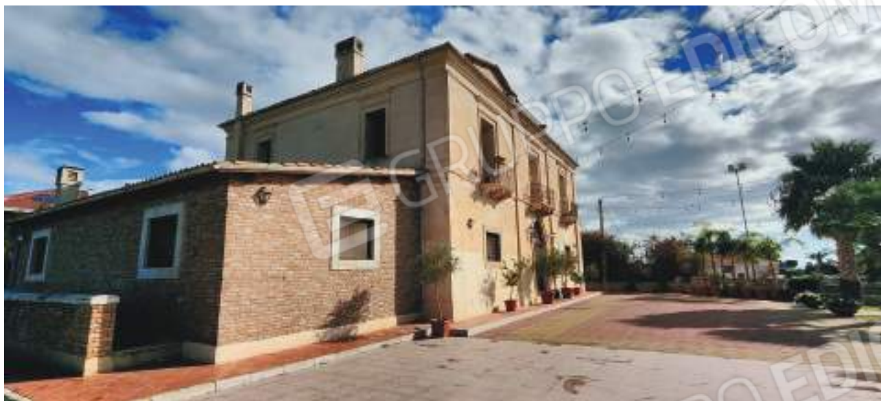
Figura 1 Veduta compendio immobiliare
