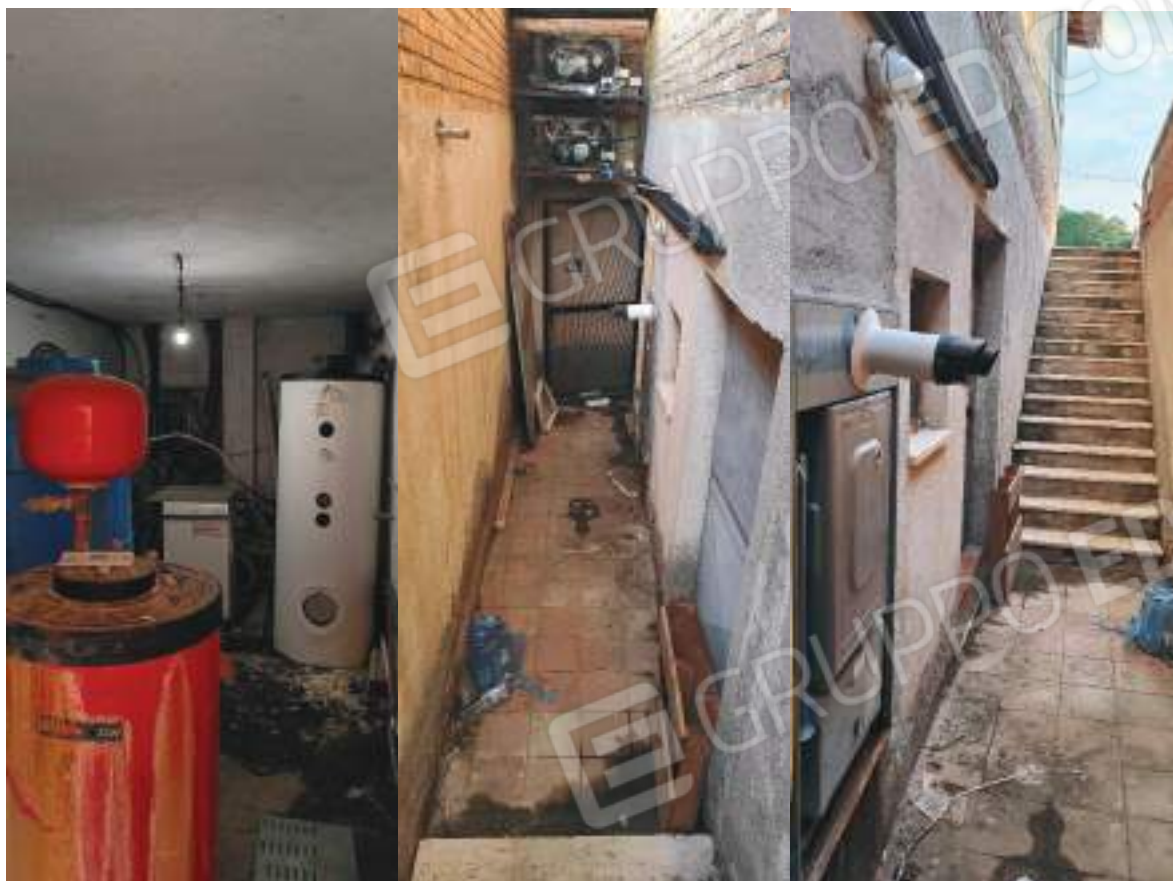
Figura 9 Scala ingresso locale tecnico e locale tecnico
