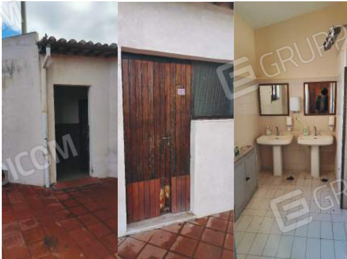
Figura 10 Particolari porte di ingresso e antibagno locali servizi igienici esterni
