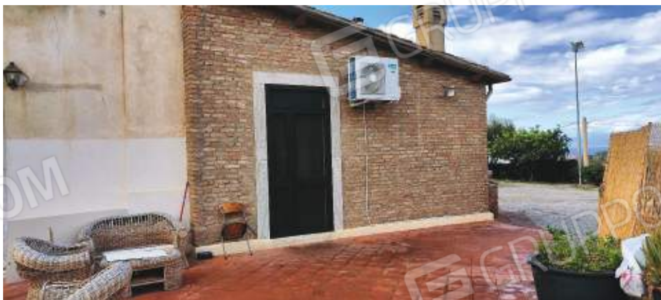
Figura 5 Particolare prospetto posteriore
