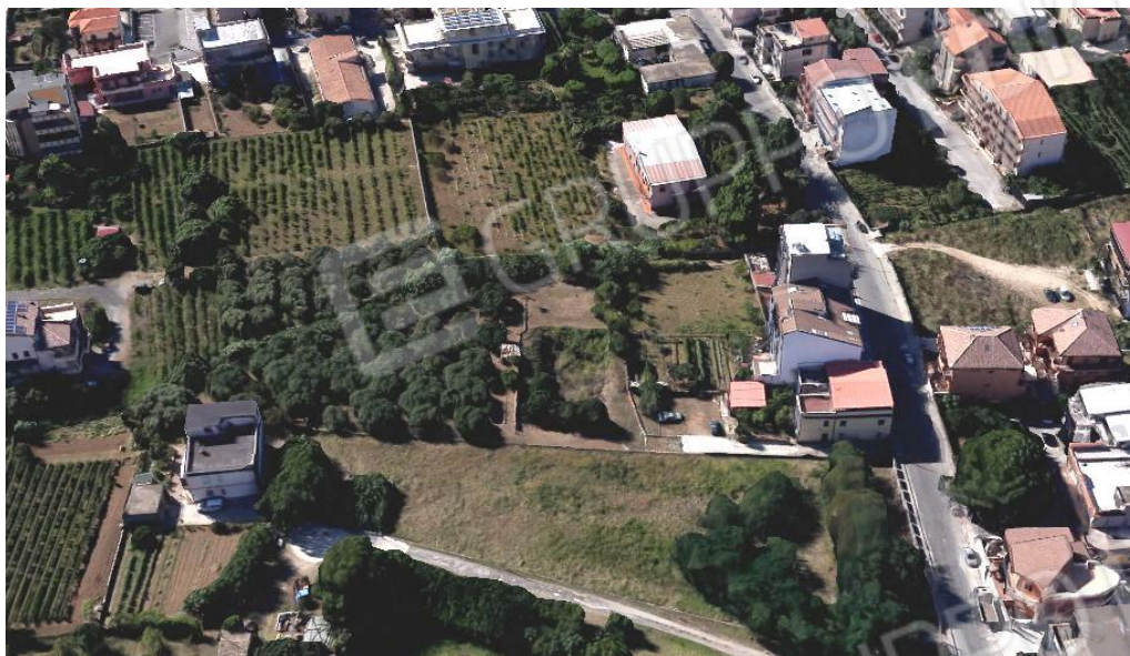
Foto n° 3 Vista aerea degli immobili
