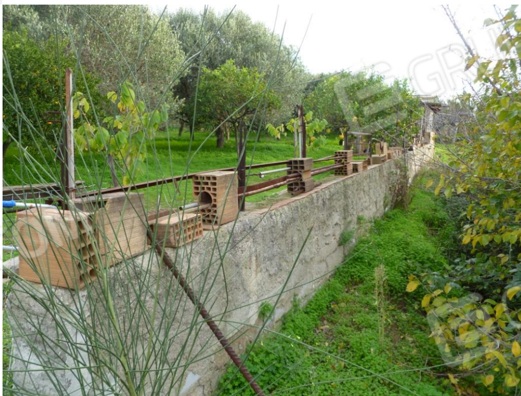
Foto n° 6 Muro di confine tra la particella 472 e la particella 370
