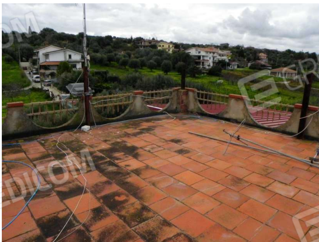
Foto 4 – Lastrico solare a copertura sub 7
