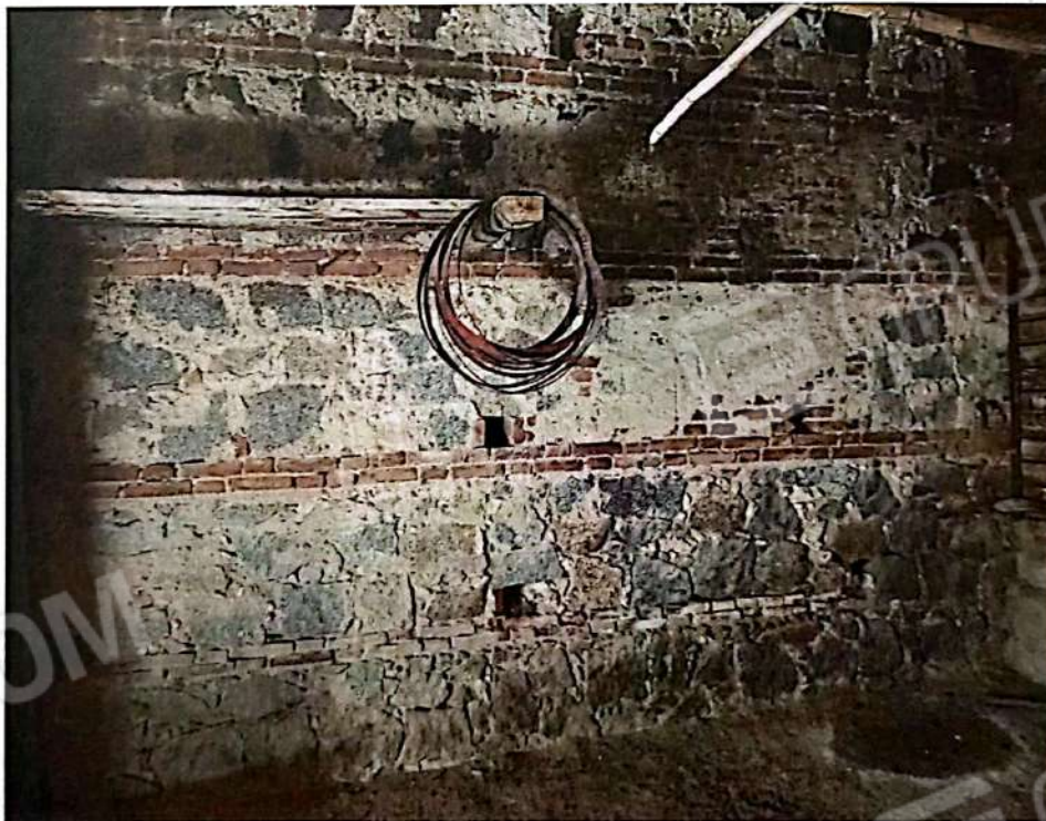
Foto 2 garage N.C.E.U Nicotera fg. 3 - p.lla 710 sub 1
