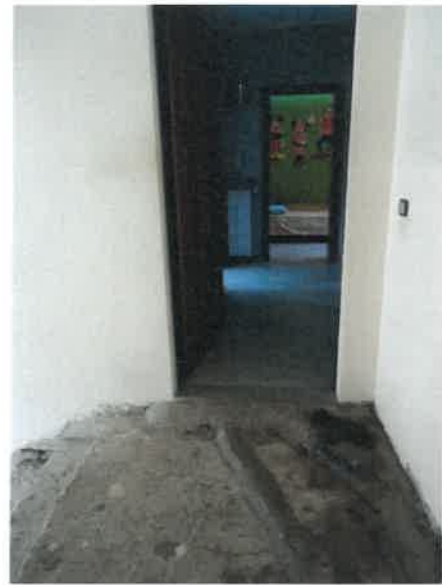
Ingresso al sub 1105
