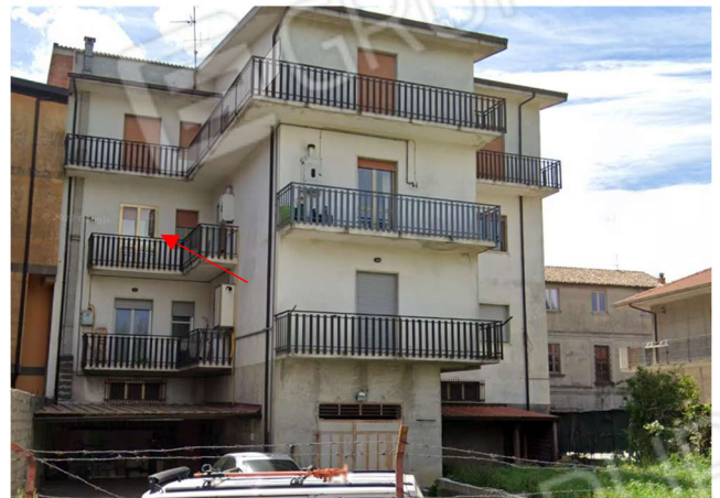
Vista del fabbricato da Via a. Gramsci
