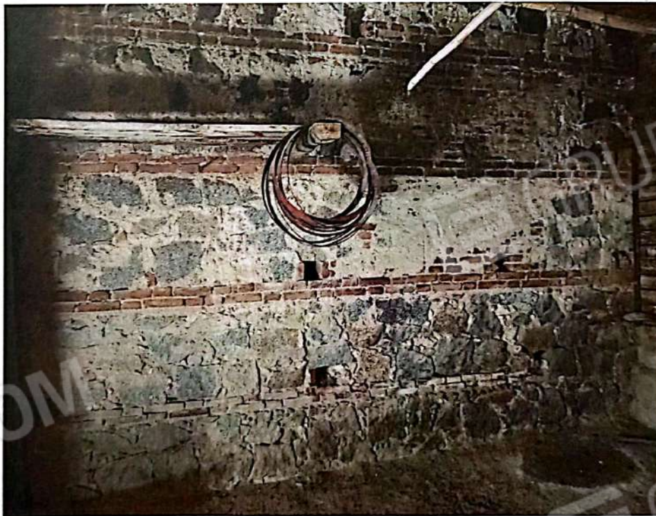
Foto 2 garage N.C.E.U Nicotera fg. 3 - p.lla 710 sub 1
