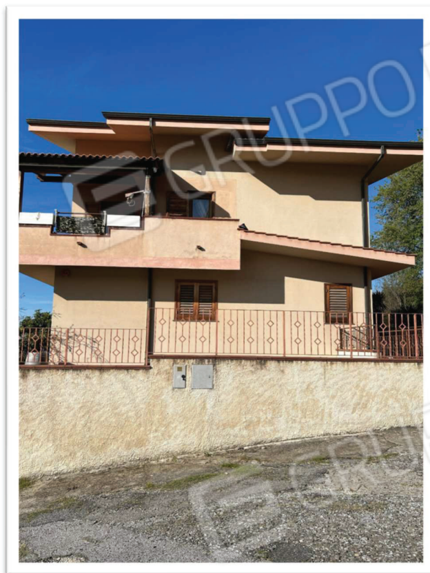
Foto n.1 - Veduta esterna da strada comunale dell'edificio che ospita le unità immobiliari pignorate.
