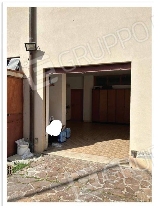
Foto n.5 - Magazzino (sub 10): Ingresso posto sulla corte comune del piano seminterrato.
