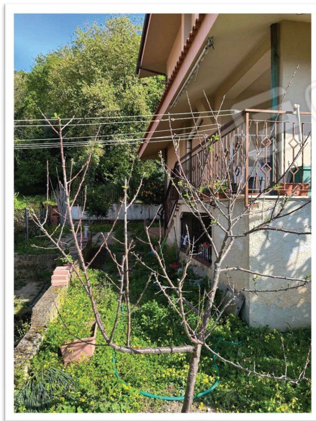
Foto n.10 - Corte annessa al magazzino (sub 10): Porzione posta sul retro dell'edificio.
