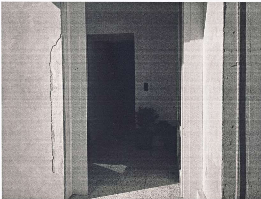
Foto 1 Ingresso Fabbricato fg. 5 - p.lla 293 sub 5
