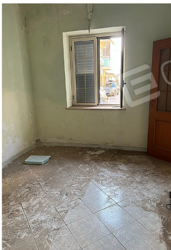
Foto 4 – Camera al piano terra.
