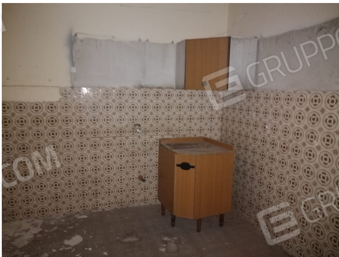
Foto 6 – Cucina al piano terra.
