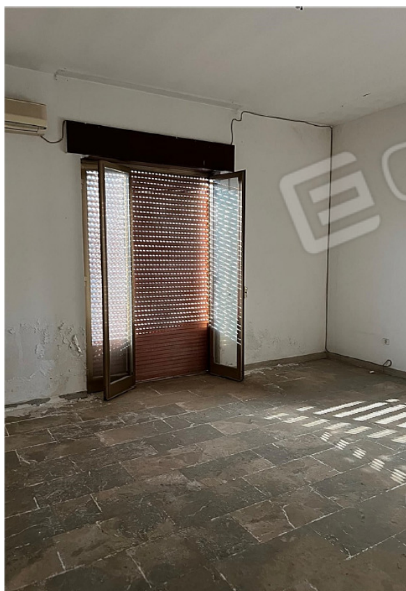
Foto 10 – Prima camera del piano primo.
