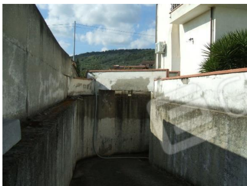
Rampa di accesso al piano seminterrato
