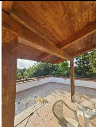
foto 17. Dettaglio part. 521 sub. 7
