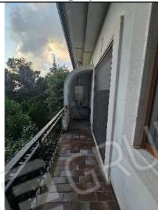
foto 22. Dettaglio part. 521 sub. 7
