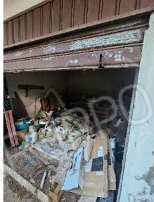
foto 36. Dettaglio part. 521 sub. 4
