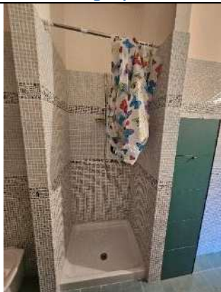
foto 29. Dettaglio part. 521 sub. 7
