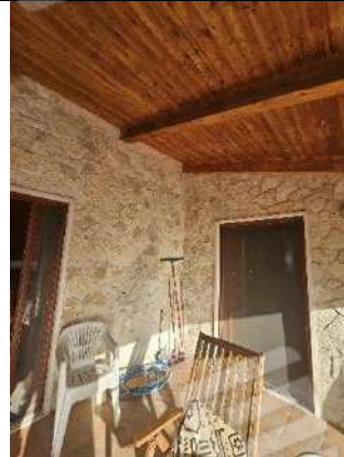
foto 16. Dettaglio part. 521 sub. 7
