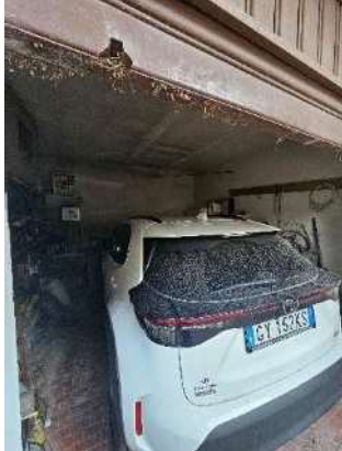
foto 35. Dettaglio part. 521 sub. 4
