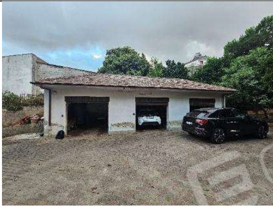
foto 33. Dettaglio part. 521 sub. 4
