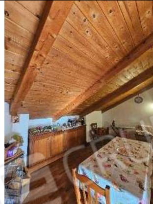
foto 14. Dettaglio part. 521 sub. 7
