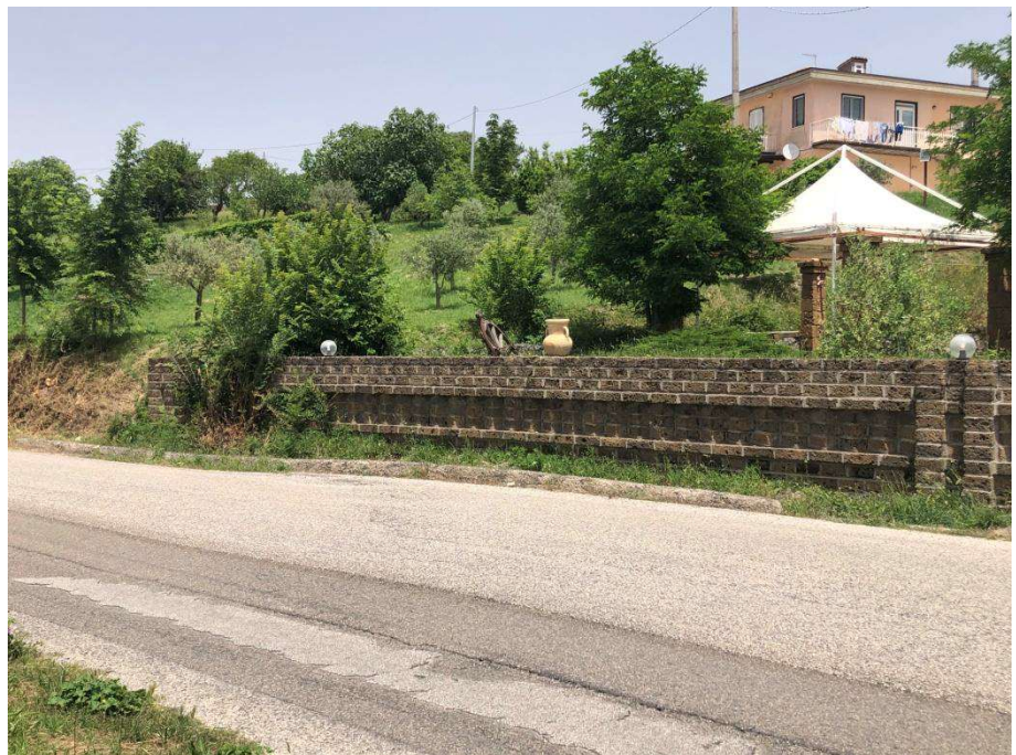
Muro su confine tra viabilità comunale e particella 639
