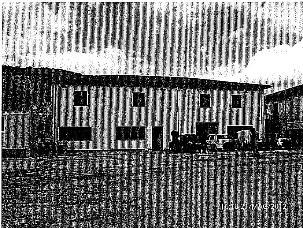
Foto 11: Fabbricato uffici e servizi, blocco lato sinistro
