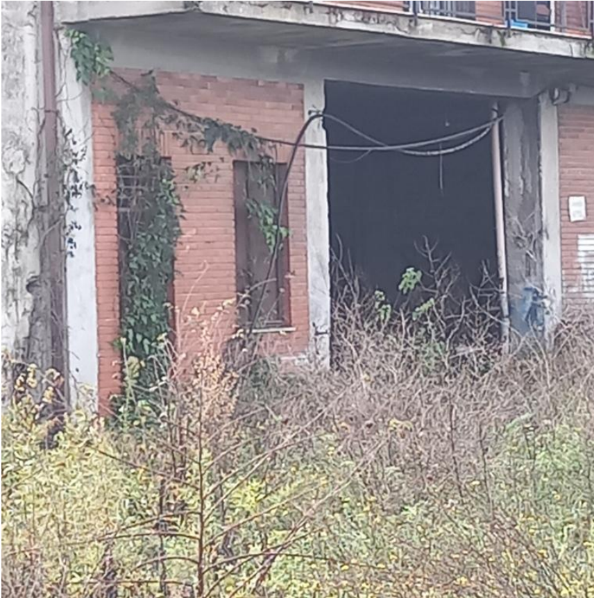
In primo piano l'immobile di cui al fg.74 p.la 221 sub.5 oggetto di perizia.
