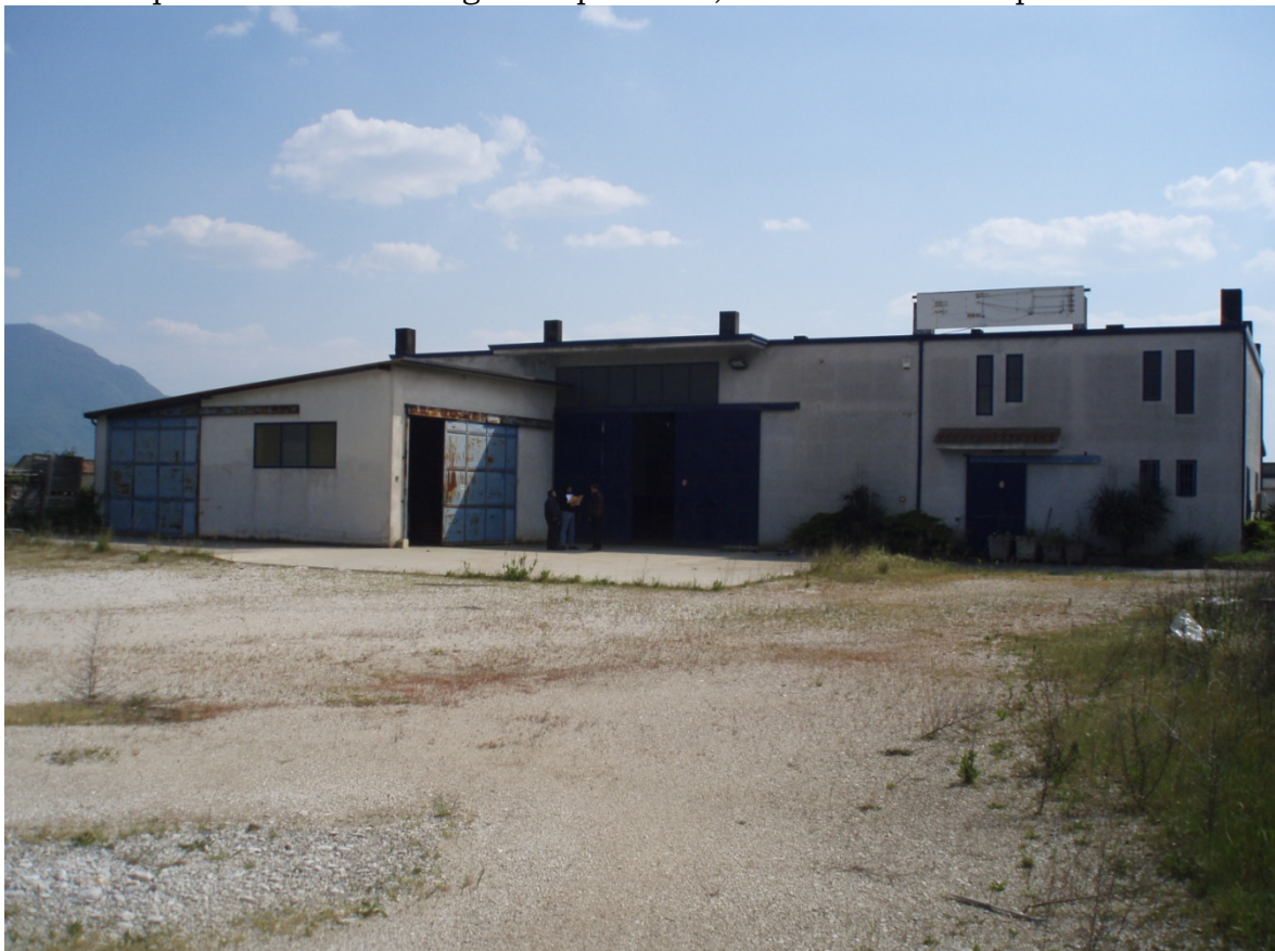
Fronte principale opificio foglio14 p.lla 331, 331 subb. 1 e 2
