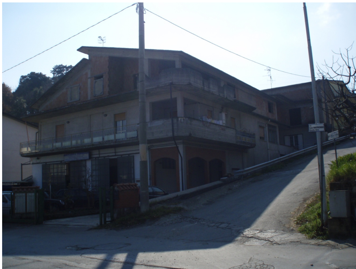
Edificio con corte foglio 17 p.lla 381 e 381 subb. 1, 2 e 3
