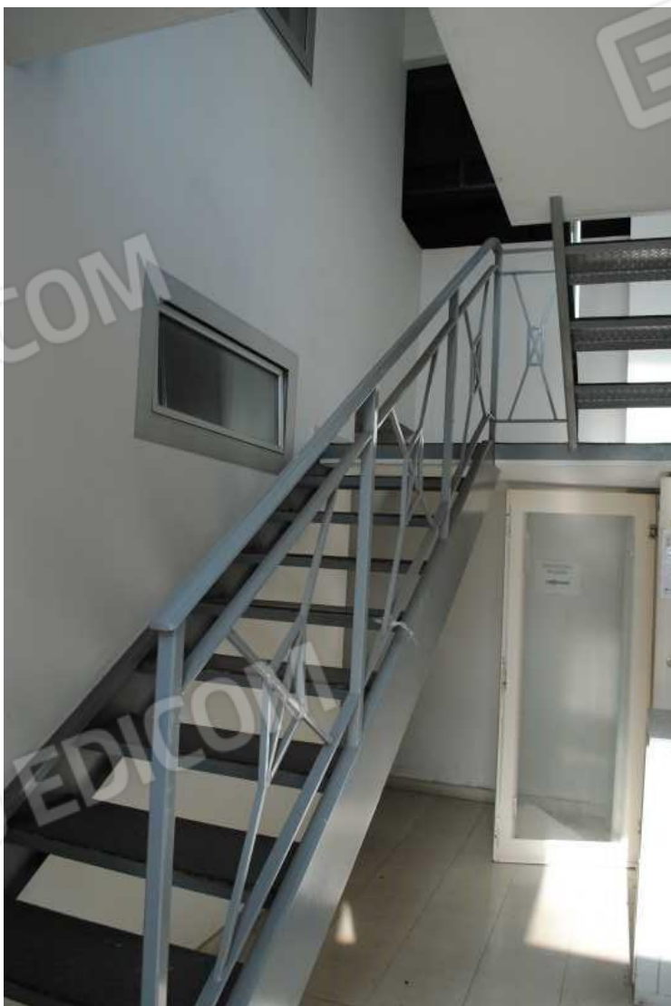
Corpo 1 - Edificio Officina con Uffici - interno struttura uffici piano primo
