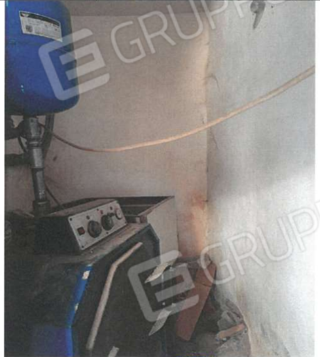
PIANO TERRA LOCALE DEPOSITO 2
