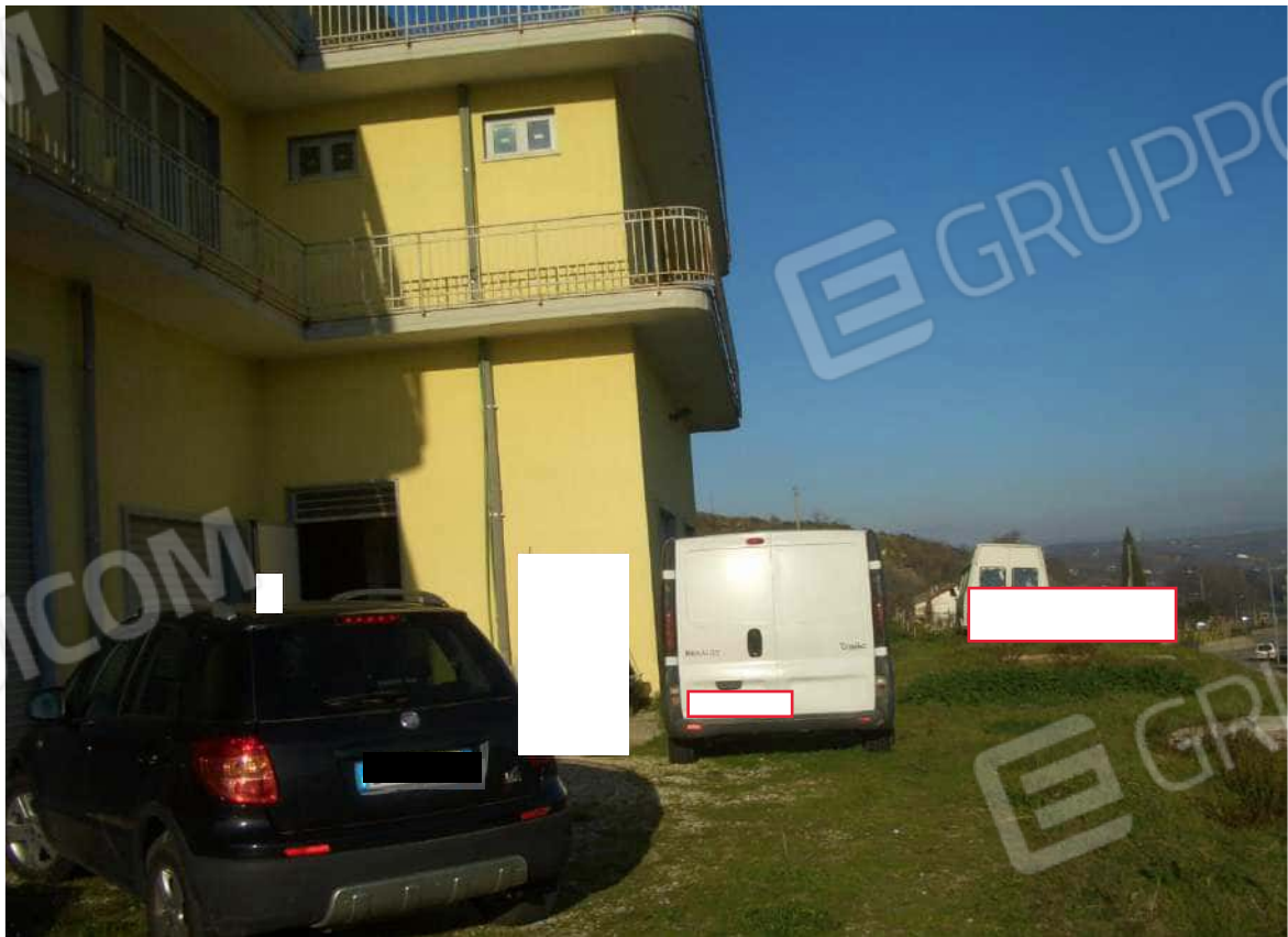
Foto n. 4:...Scorcio prospetto posteriore...
