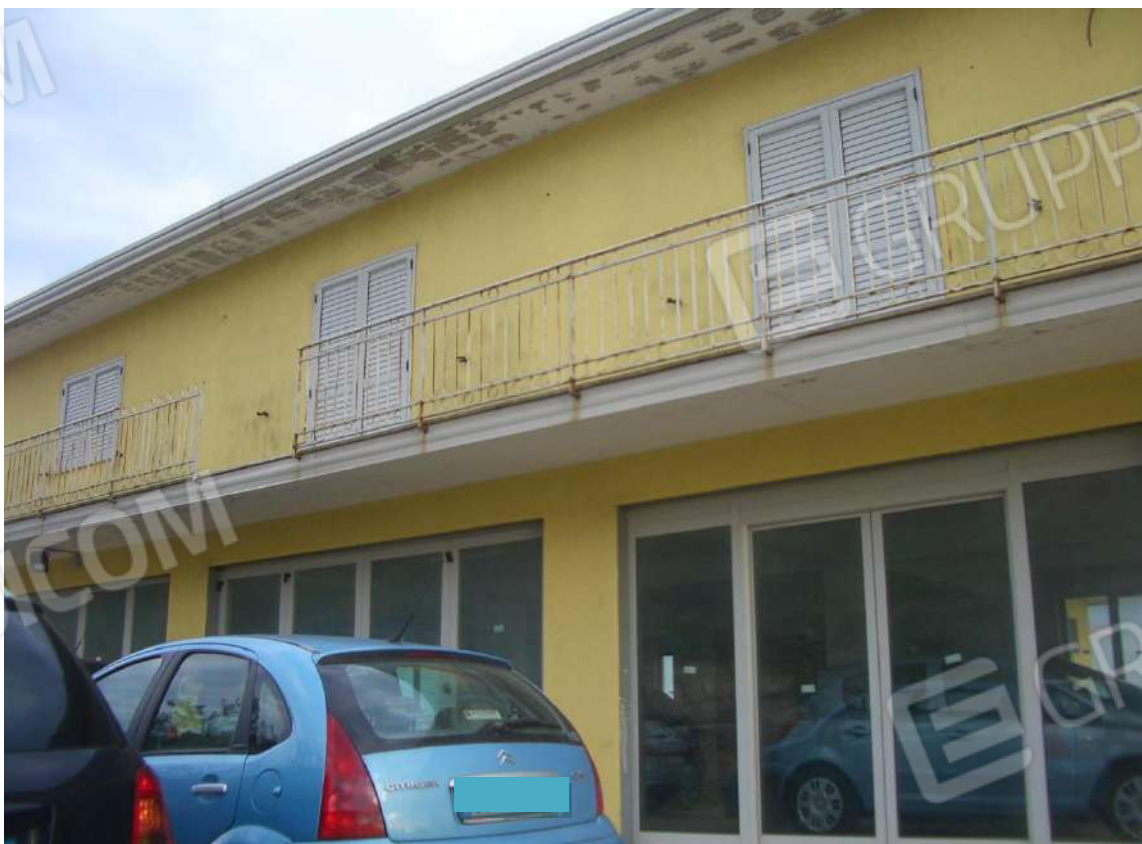
Foto n. 2: ...Scorcio prospetto principale ...
