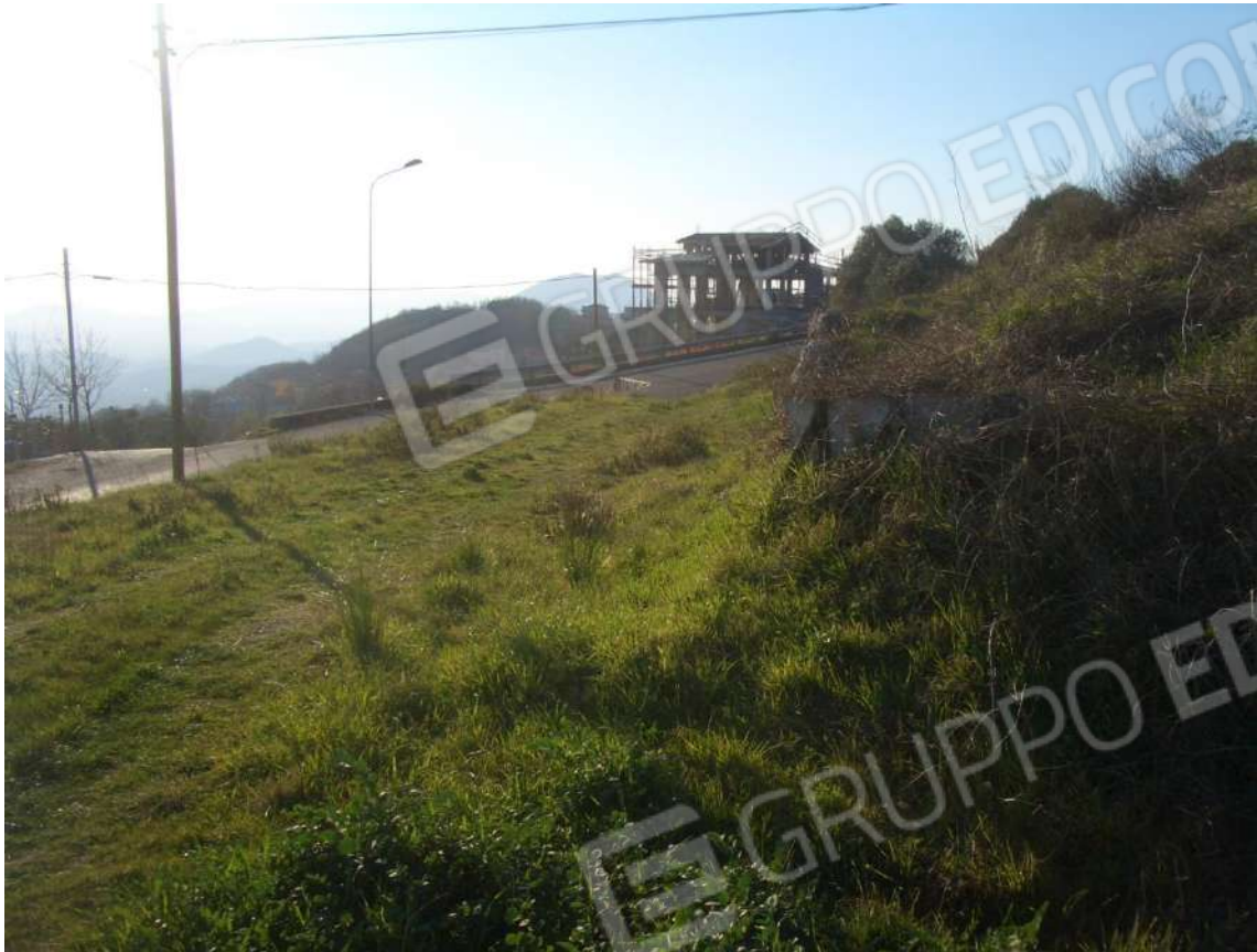
Foto n. 11: ...Attuale strada di accesso al Piano Seminterrato...
