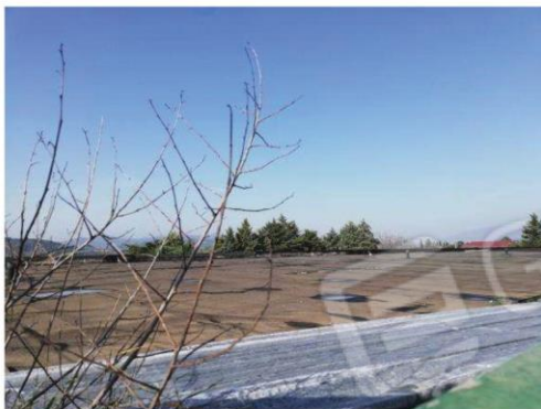
foto 41: ... stato della copertura
