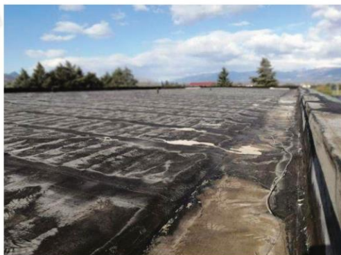
foto 53: ... stato della copertura
