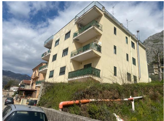
Particolare facciata del fabbricato dalla strada pubblica
