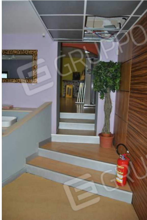
Foto 11 – 21.01.2016 – Area d'ingresso fabbricato p.lla 442; vista sia dell'apertura realizzata per accedere al fabbricato retrostante sia della controsoffittatura
