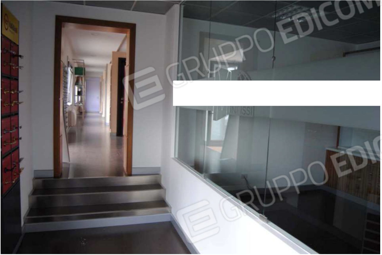
Foto 15 – 27.09.2010 – Fabbricato p.la 442 area amministrativa/commerciale
