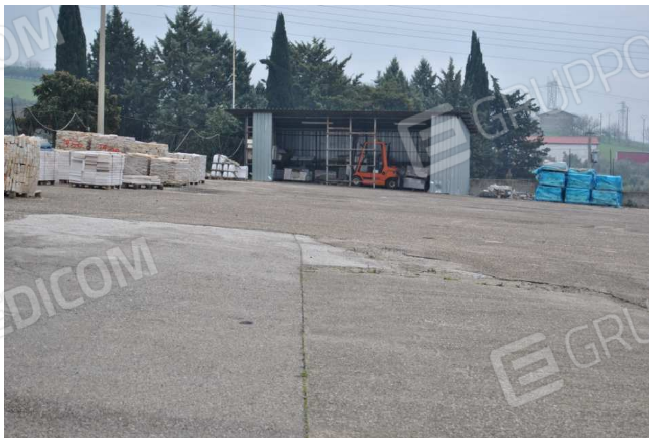
Foto 6 – 21.01.2016 – Struttura abusiva in ferro
