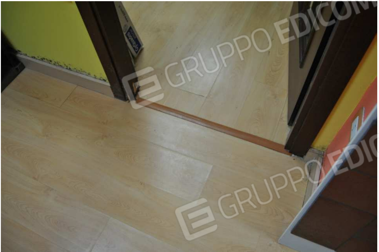
Foto 45 – 21.01.2016 – Area espositiva nel volume abusivo: sollevamento del parquet lungo le linee di fuga dei listoni
