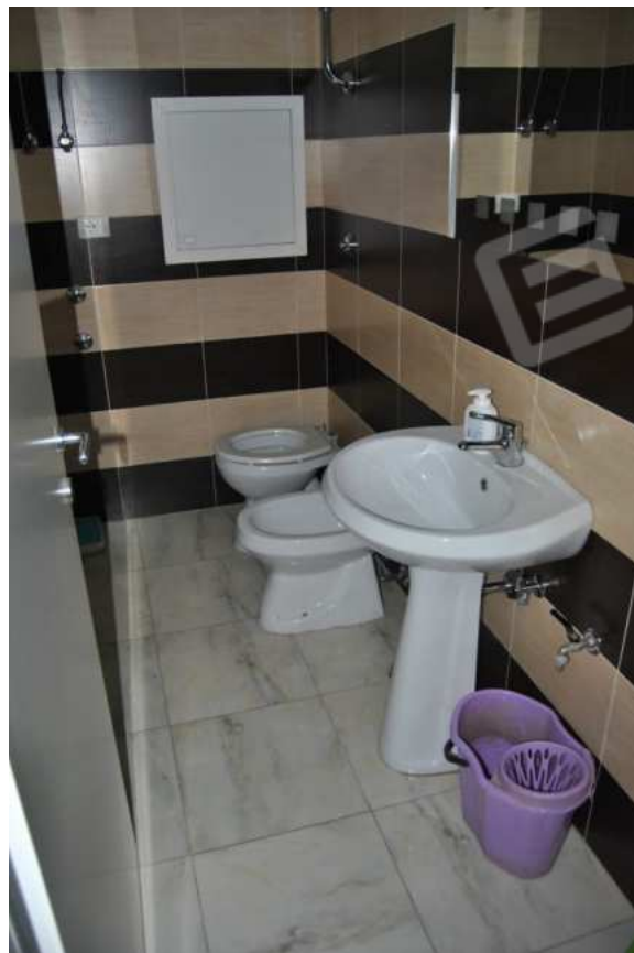
Foto 24 – 21.01.2016 – Fabbricato p.la 442 area amministrativa/commerciale: assenza di danni nel locale bagno
