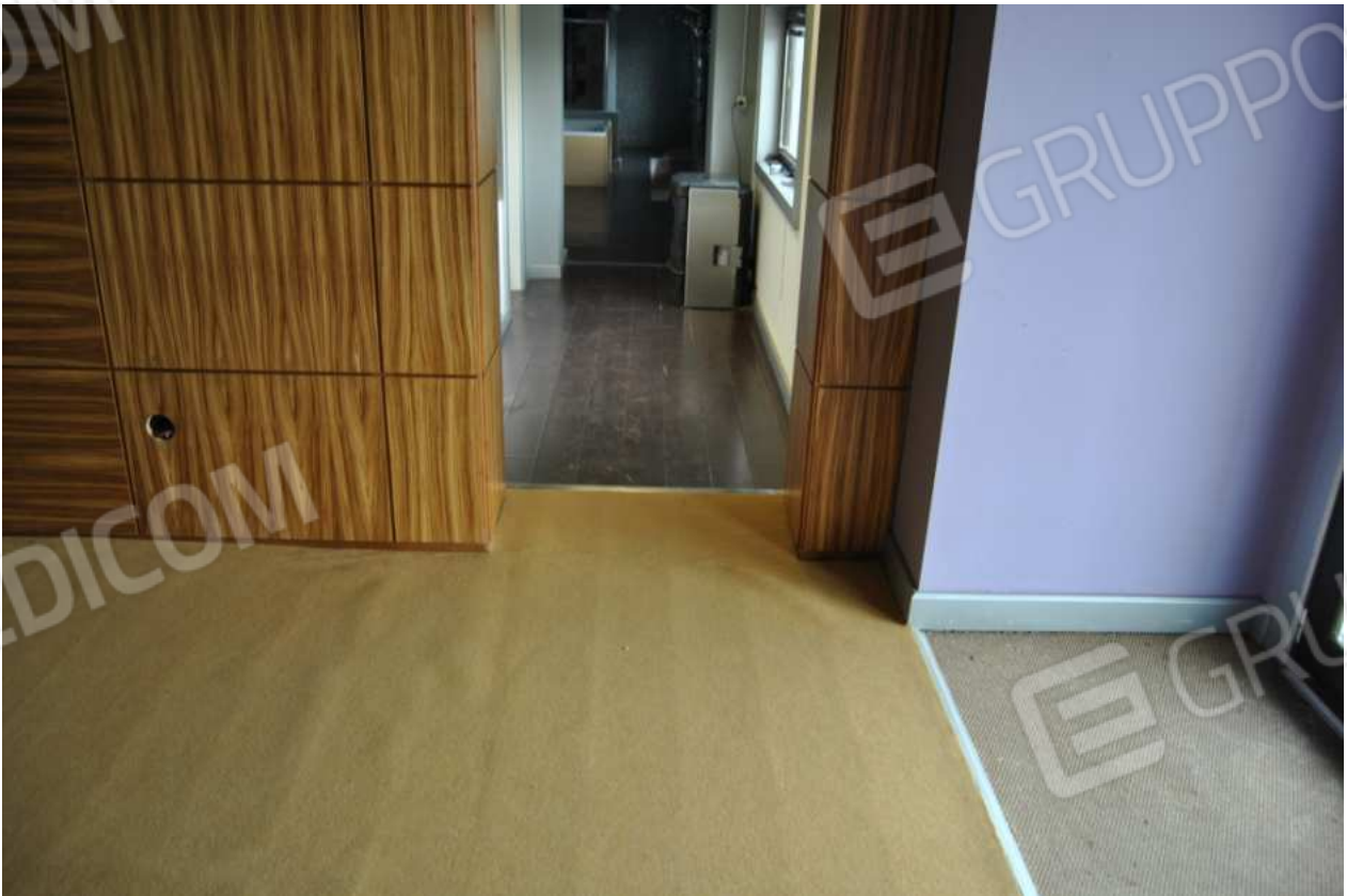
Foto 12 – 21.01.2016 – Area d'ingresso al fabbricato p.lla 442 con vista del tappeto in juta e dell'accesso all'area amministrativa/commerciale
