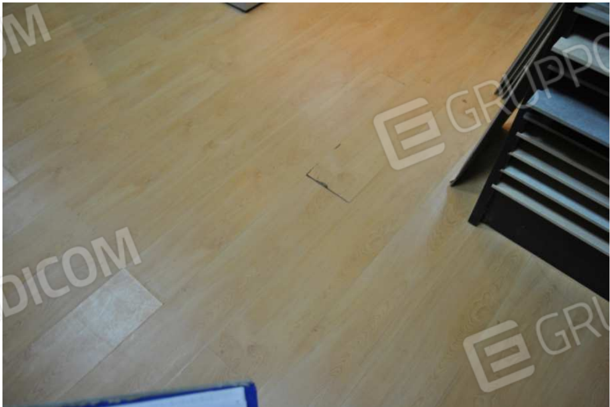
Foto 42 – 21.01.2016 – Area espositiva nel volume abusivo: deterioramento e sollevamento del parquet lungo le linee di fuga dei listoni
