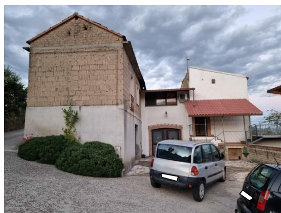
Particolare facciata del fabbricato dalla strada pubblica
