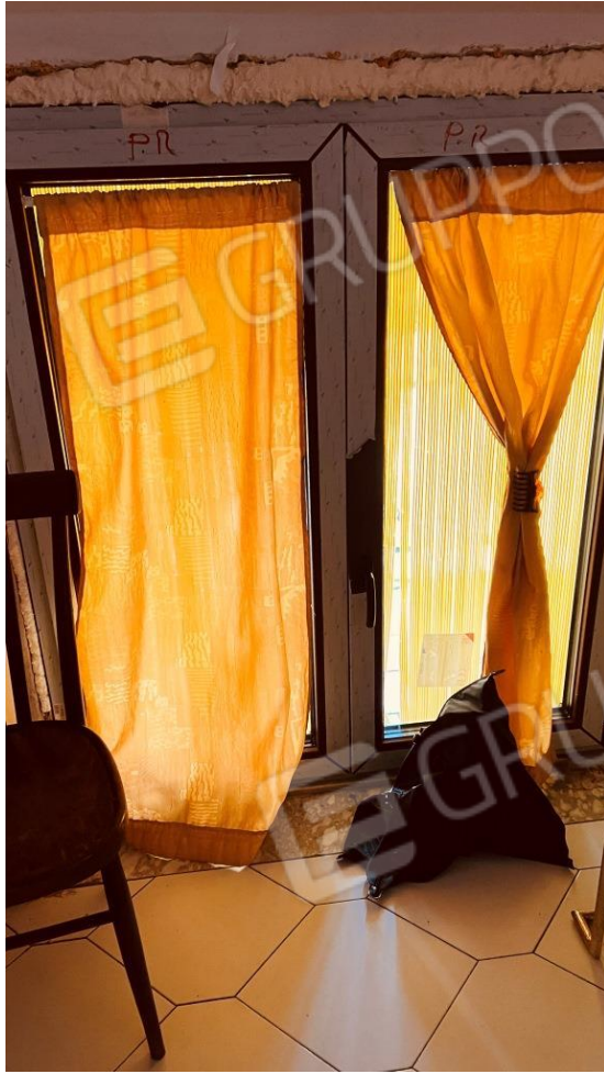
Foto 8 – dettaglio dell'infisso esterno nel vano pranzo
