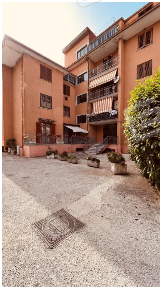
Foto 13 – Fabbricato di cui alla scala A del Parco Rondine
