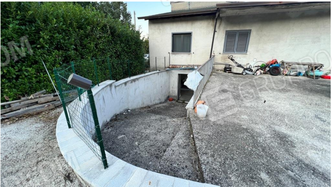
Foto 16 – Rampa di accesso al piano interrato
