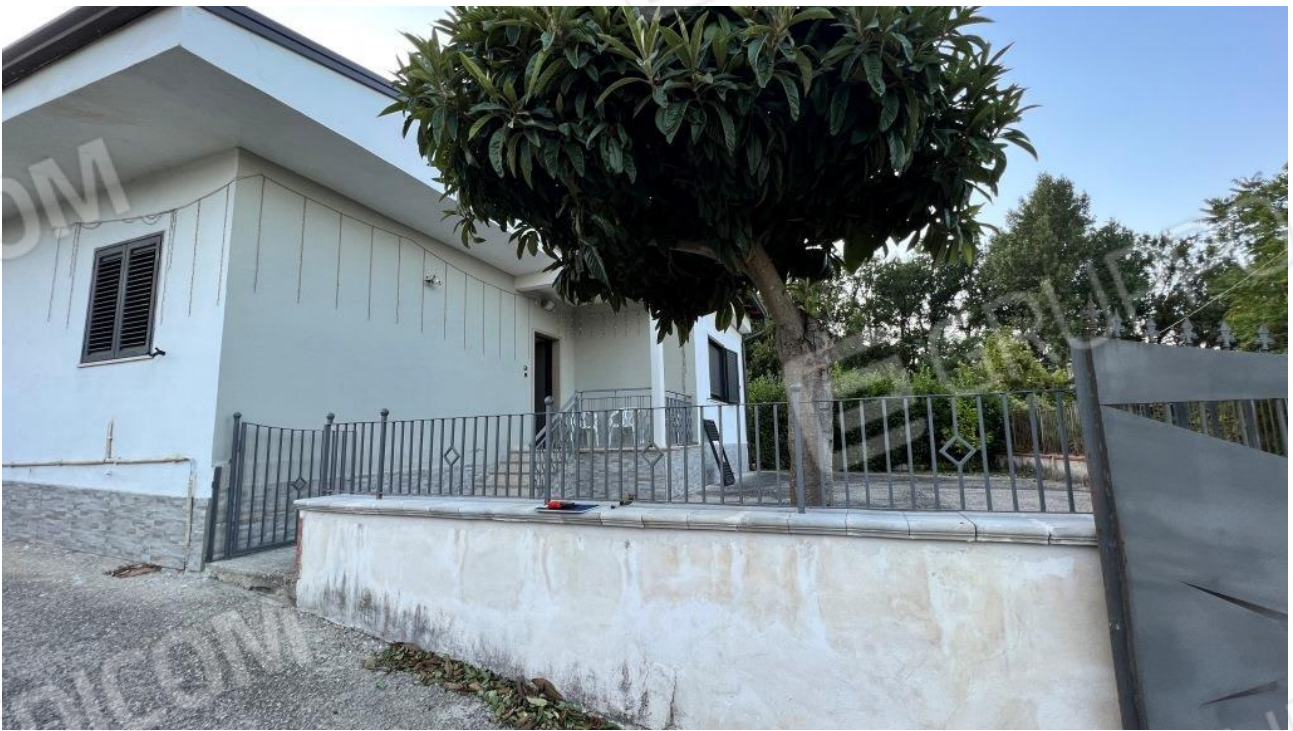
Foto 2 – Area di accesso all'abitazione delimitata da inferriata
