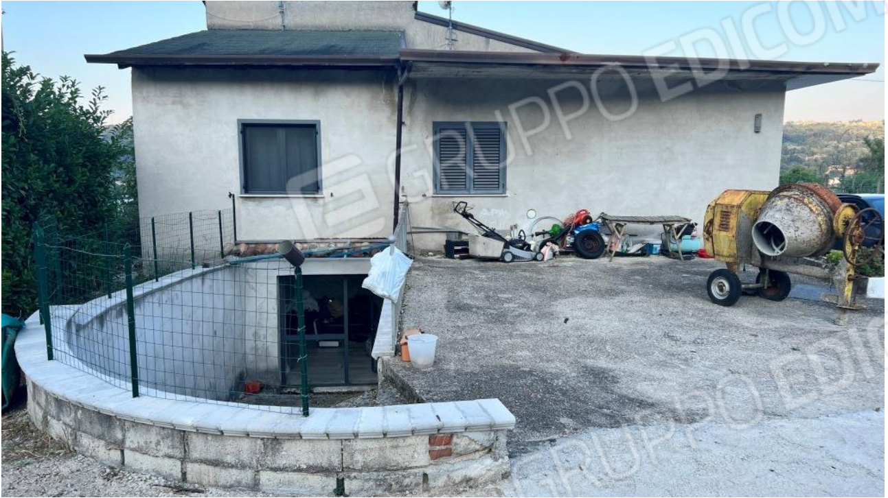
Foto 15 – Vista posteriore dell'abitazione lato OVEST
