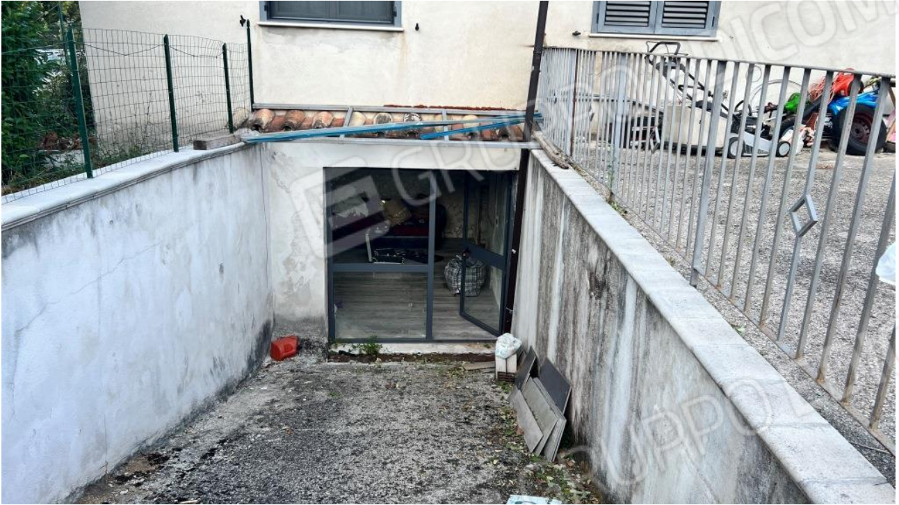
Foto 17 – Ingresso al piano interrato
