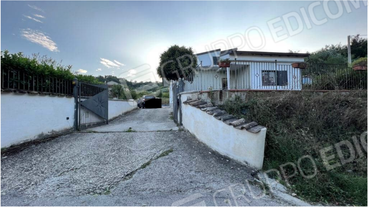
Foto 1 – Accesso all'immobile dalla via Pozzetiello
