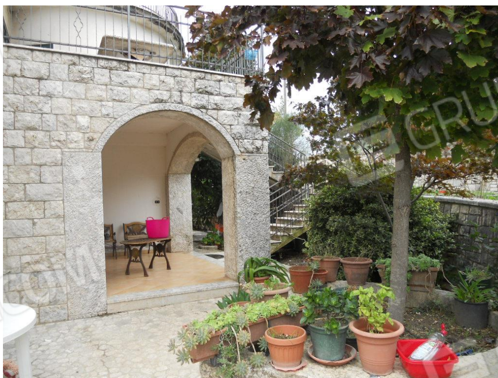
Foto 6 – Loggia lato Nord
