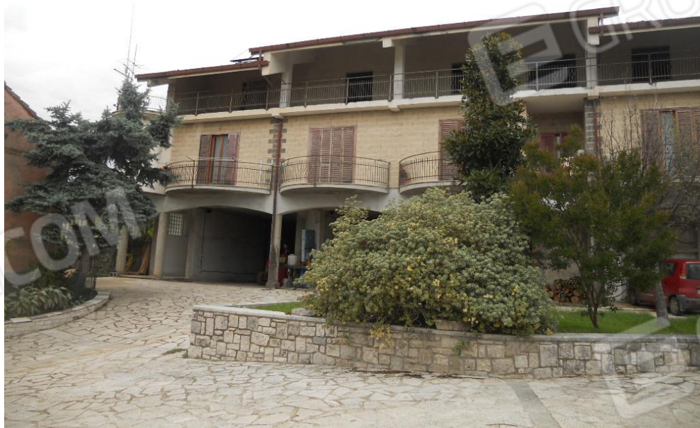
Foto 2 – Facciata posteriore su piazzale lato Sud
