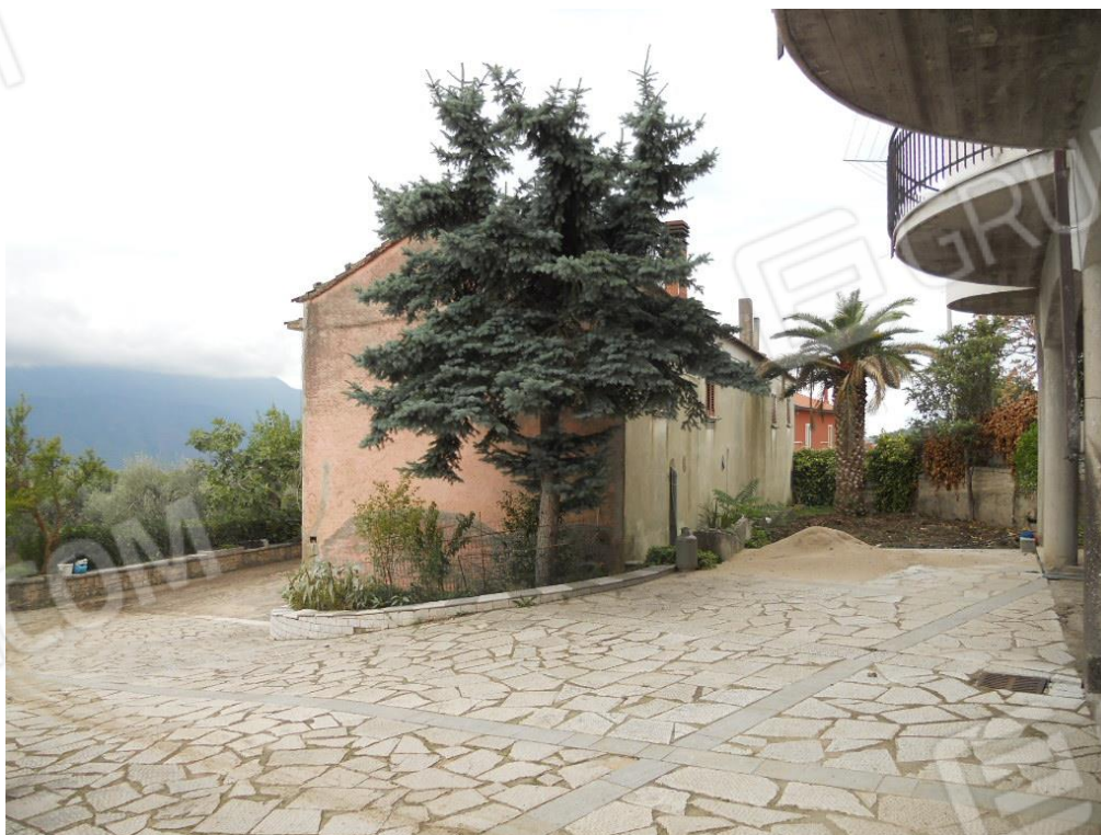
Foto 34 – Esterno – lato Sud/Est
