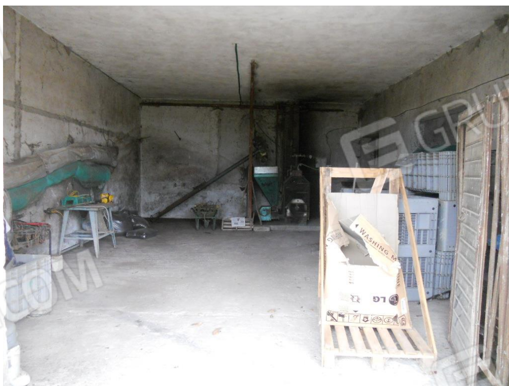
Foto 8 – Locali piano parzialmente interrato lato sx
