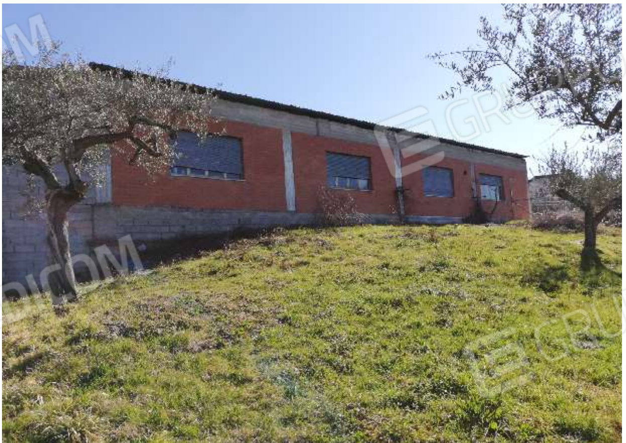
Foto n. 4: ...Scorcio del Prospetto posteriore...
