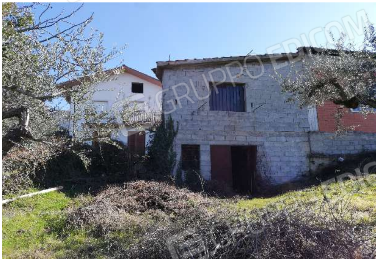
Foto n. 5:... Deposito al piano seminterrato...
