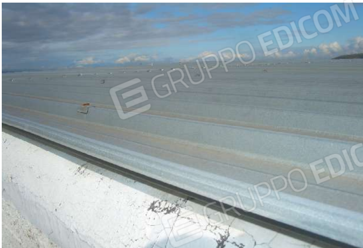
Foto n. 7: ...Particolare della copertura...
