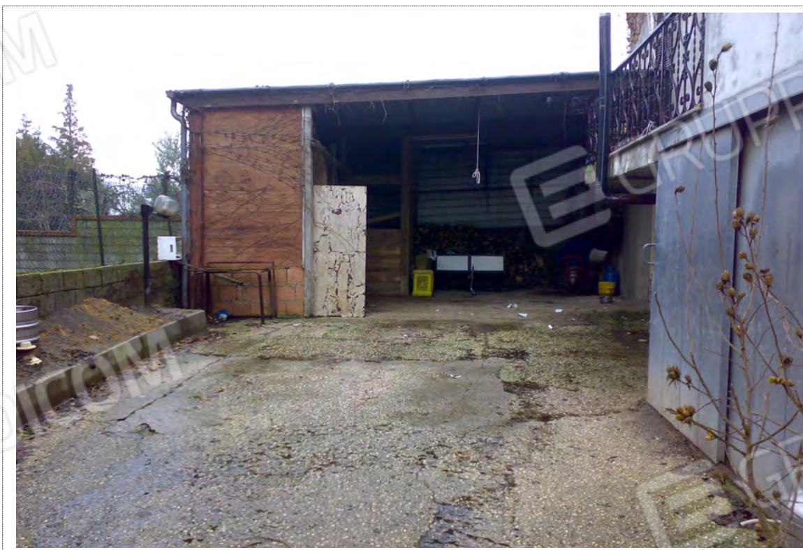
Foto n°12: Vista corte di pertinenza e locale deposito Fig. 20 p.lla 919;
