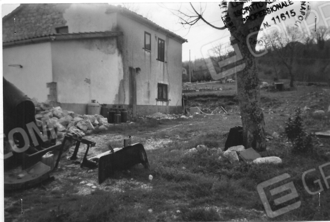
Foto n.6. Prospetto posteriore del fabbricato.
