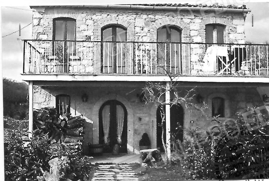
Foto n.5. Prospetto anteriore del fabbricato
