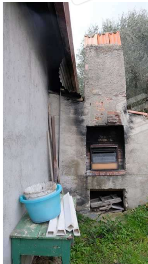
Foto 18 – Vista del forno sul lato EST del fabbricato autorimessa
