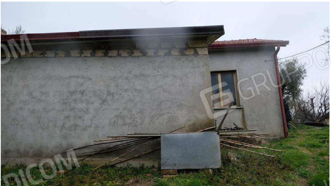
Foto 16 – Vista dell'autorimessa lato OVEST
