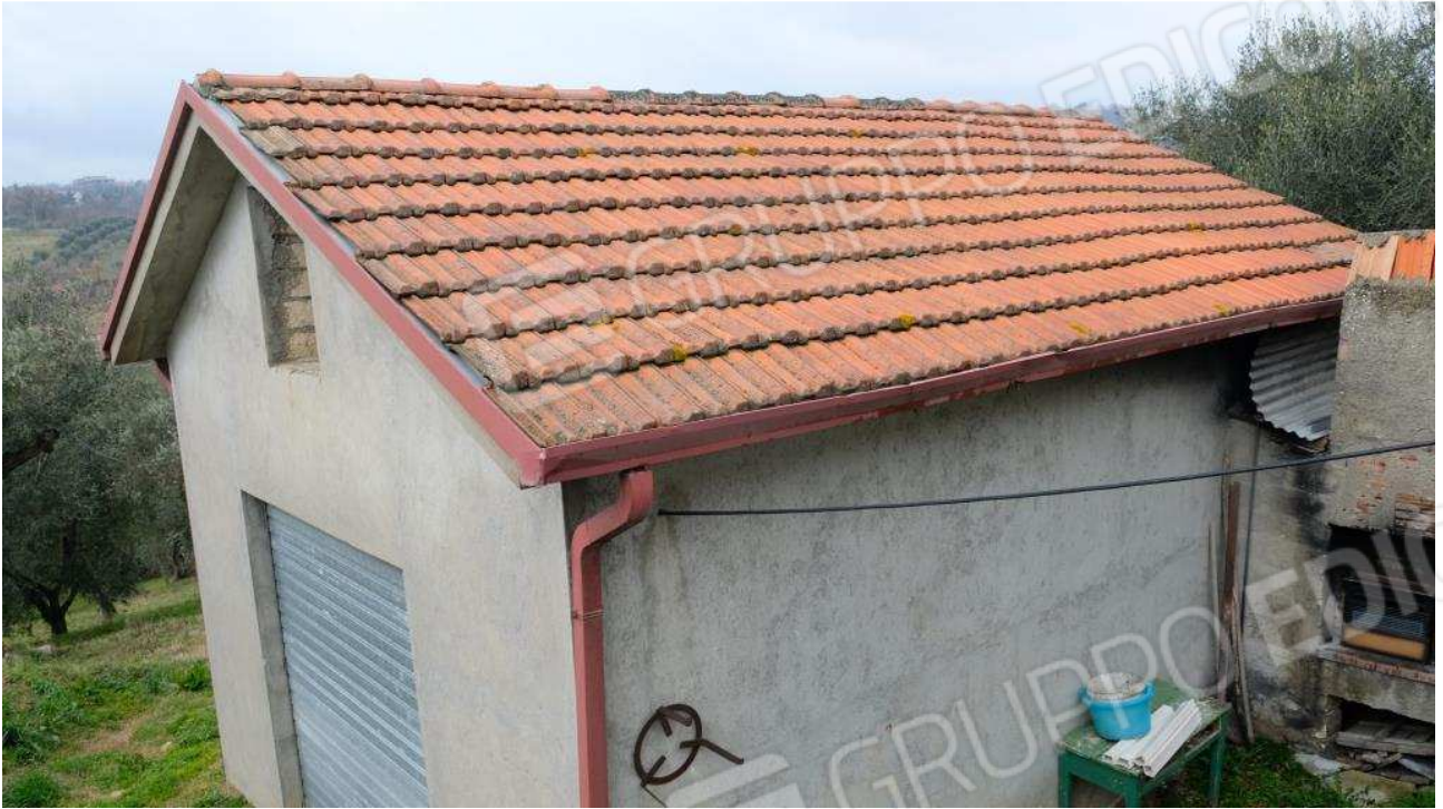
Foto 13 – Vista dell'autorimessa dal portico del fabbricato ex deposito
