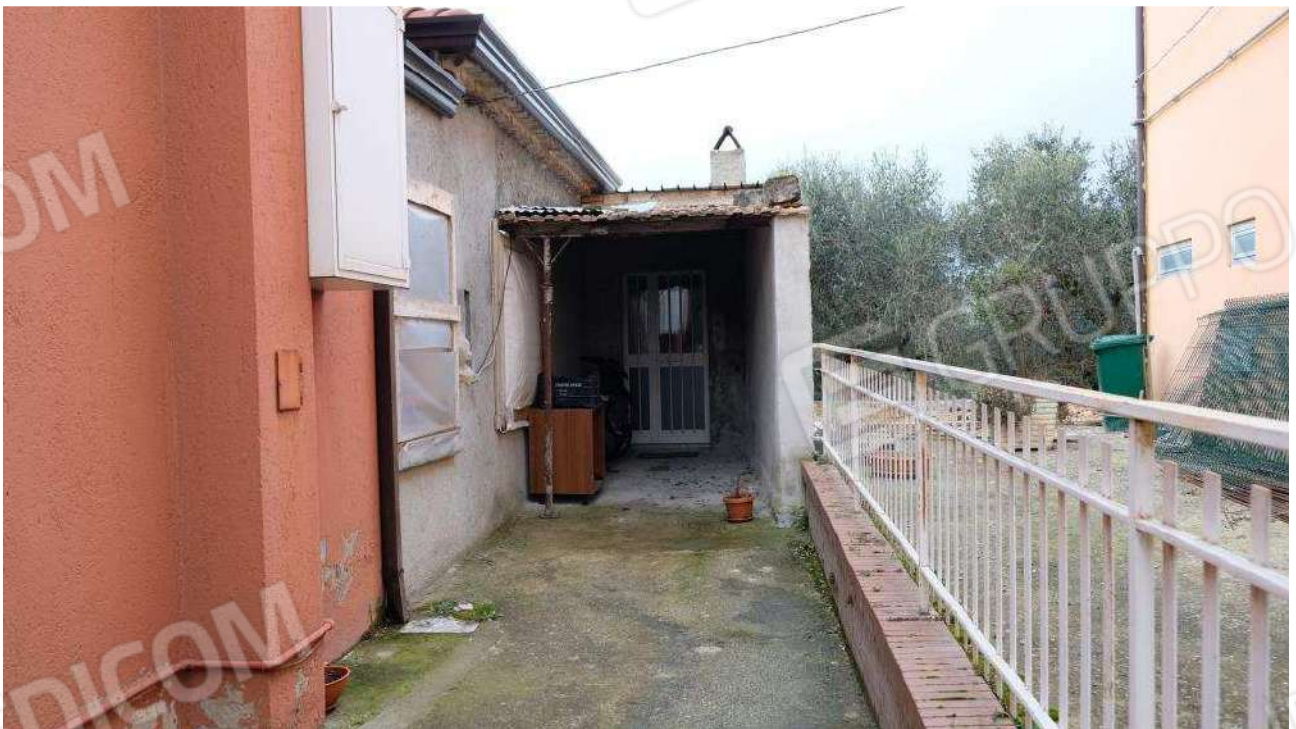
Foto 12 – Vista dell'accesso esterno al vano soggiorno dell'ex deposito dalla corte di ingresso all'abitazione
