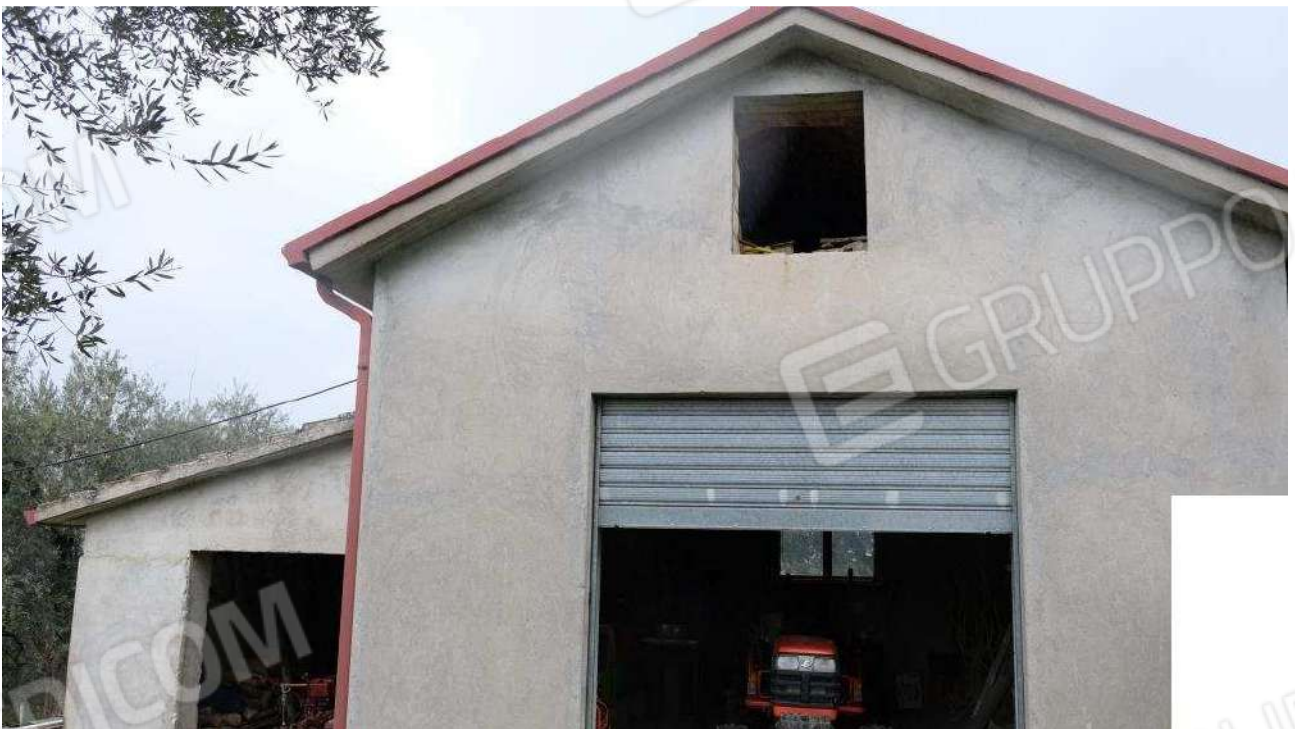
Foto 14 – Ingressi ai due vani di cui è costituita l'autorimessa
