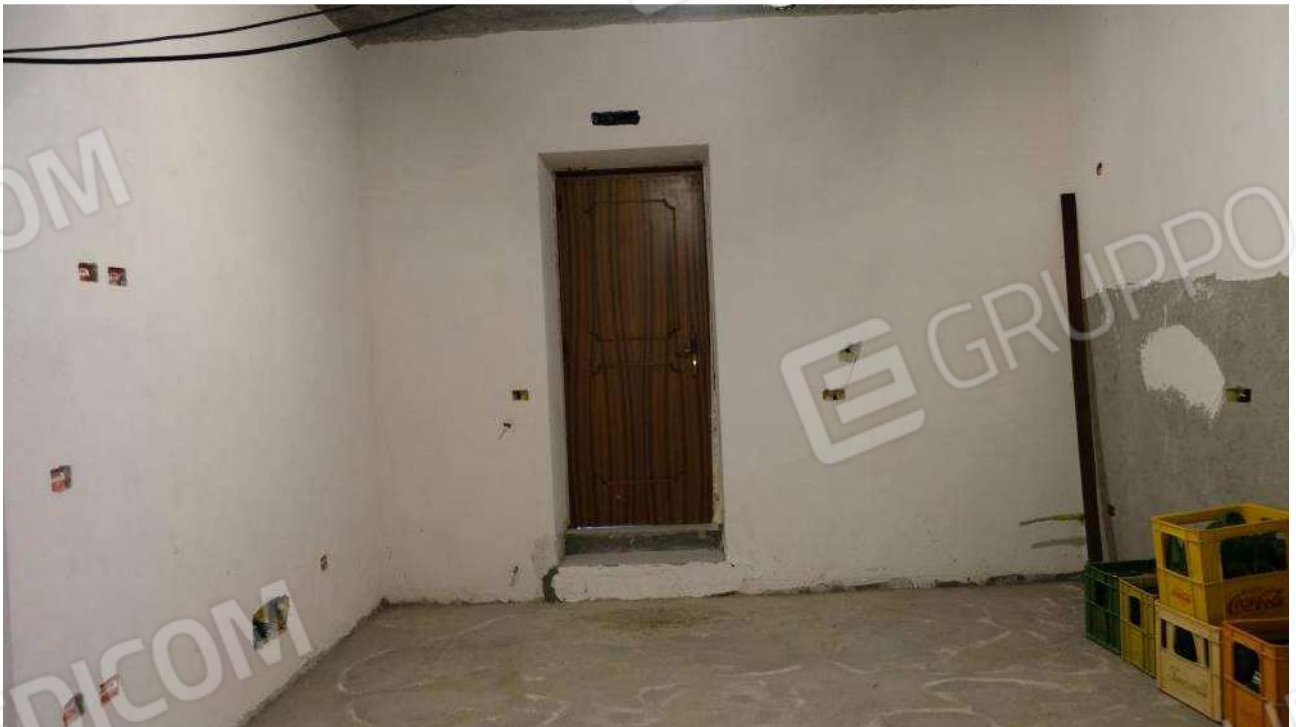
Foto 6 – Dettaglio della porta di accesso al vano soggiorno nel fabbricato ex deposito
