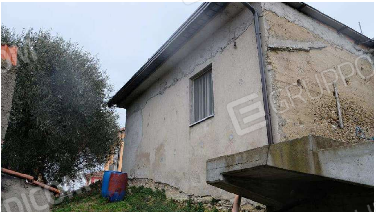
Foto 10 - Dettagli esterni nello stato rustico del fabbricato ex deposito,
