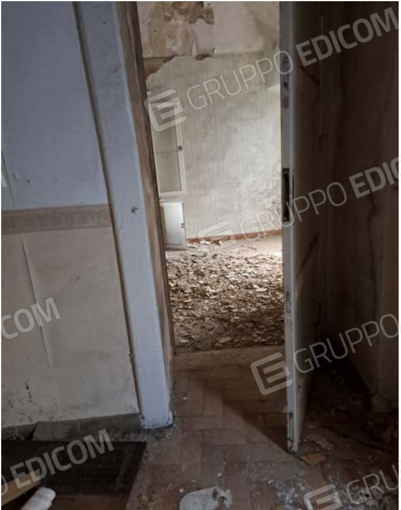
FOTO N. 4 VISTA DEL LOCALE LETTO 1
