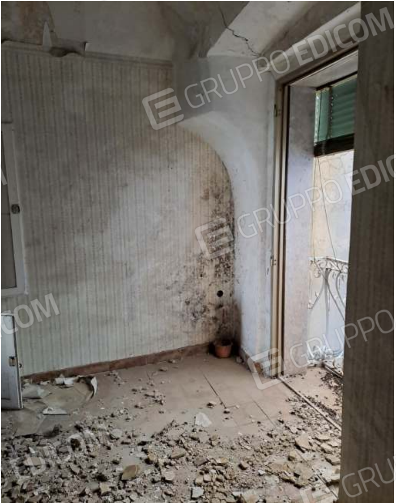
FOTO N. 5 ALTRA VISTA DEL LOCALE LETTO 1
