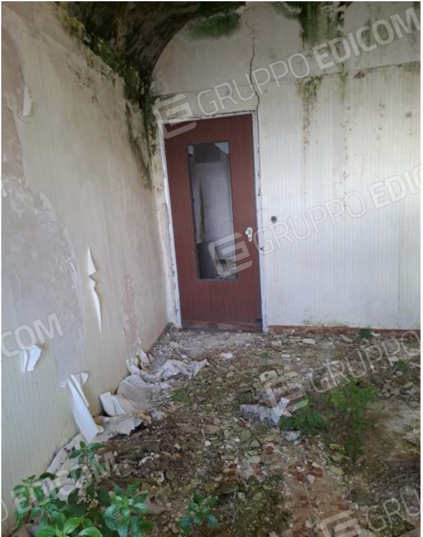
FOTO N. 6 ALTRA VISTA DEL LOCALE LETTO 2
