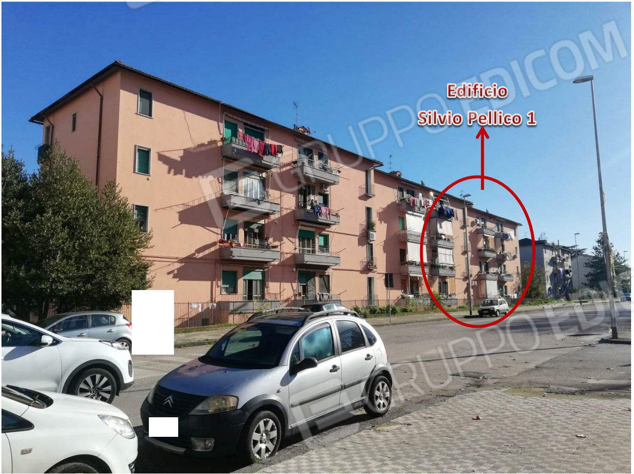
FOTO 3 _Vista da via C.B. Conte di Cavour
