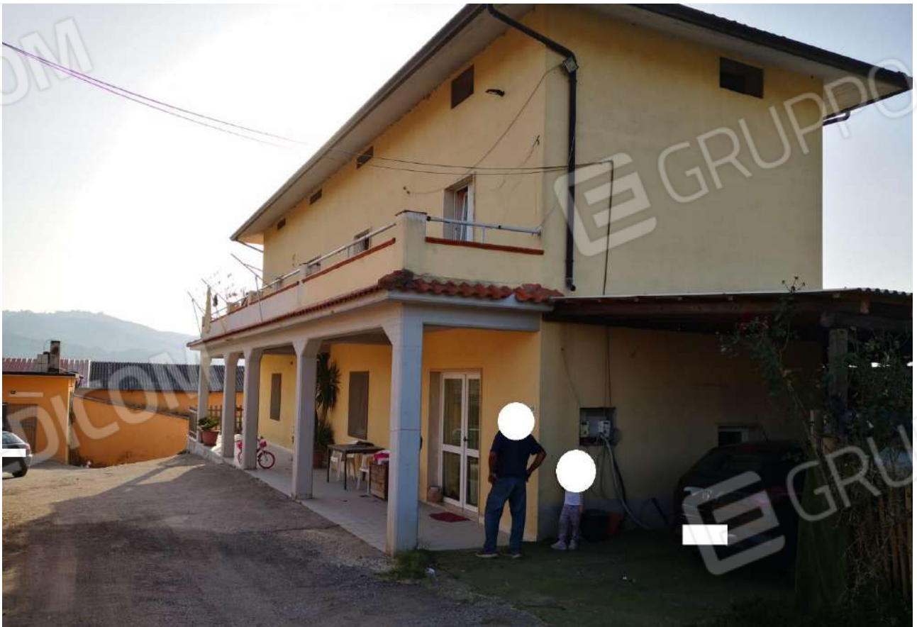
Fotogramma 04 – Fabbricato residenziale censito con il mappale 425
