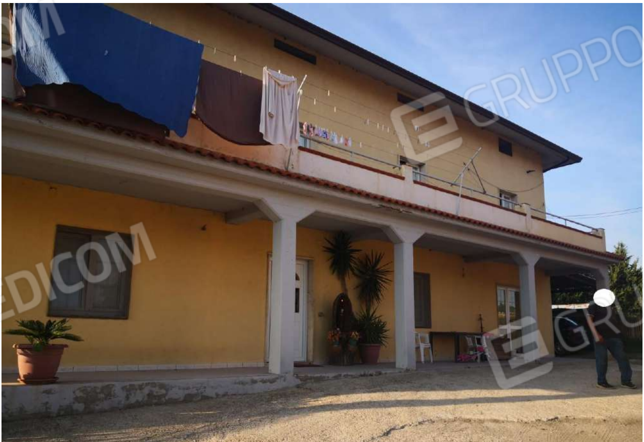
Fotogramma 06 – Fabbricato residenziale censito con il mappale 425
