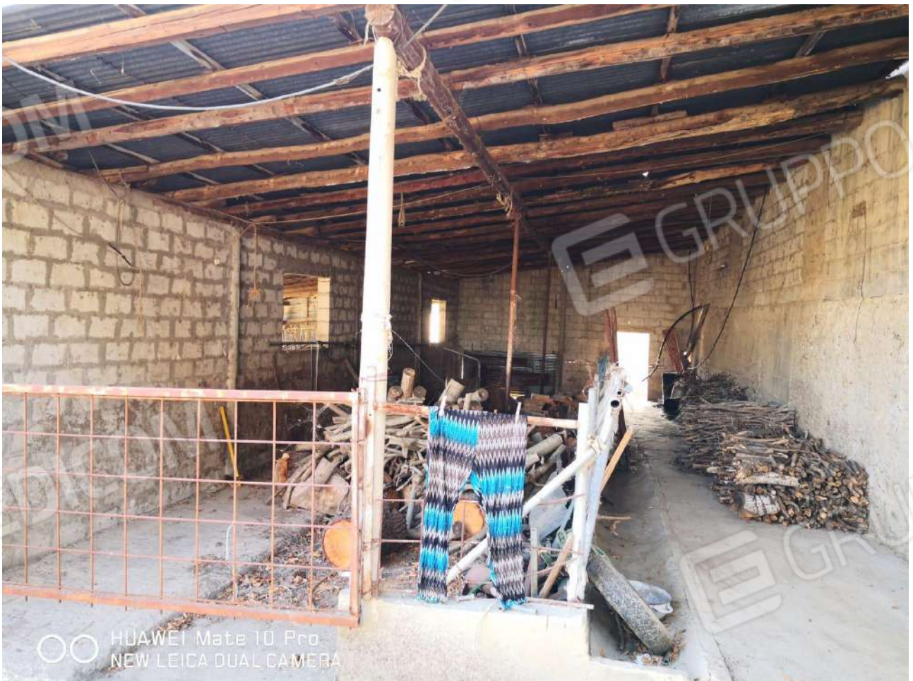
Fotogramma 50 – Deposito collocato a est delle costruzioni pertinenziali - p.lla 576
