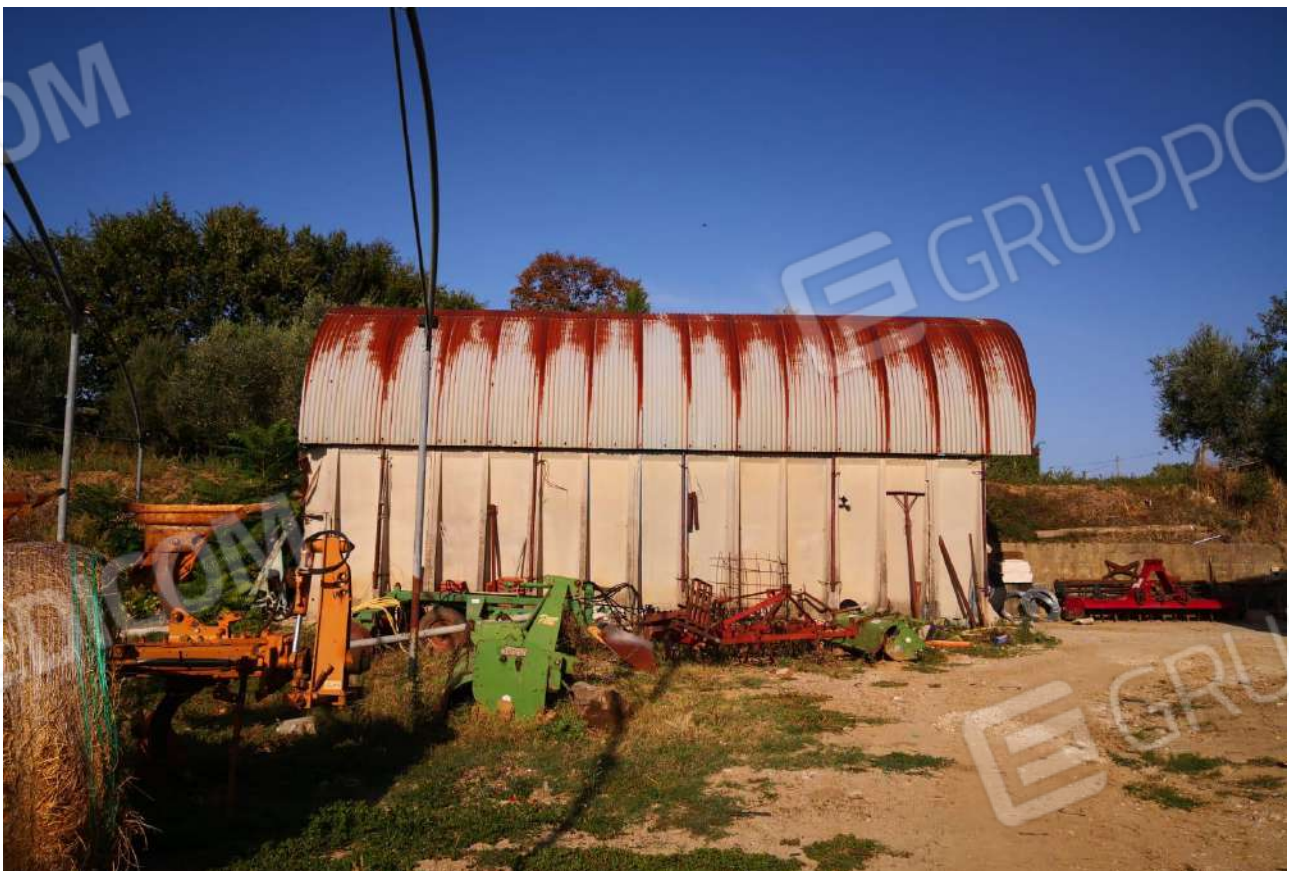
Fotogramma 48 – Deposito annesso alle costruzioni pertinenziali della p.la 576
