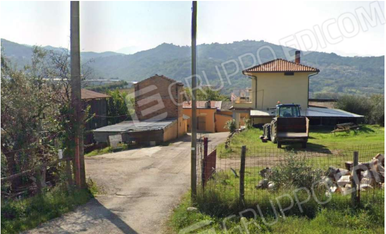
Fotogramma 03 – Vista dalla viabilità pubblica del compendio immobiliare staggiato
