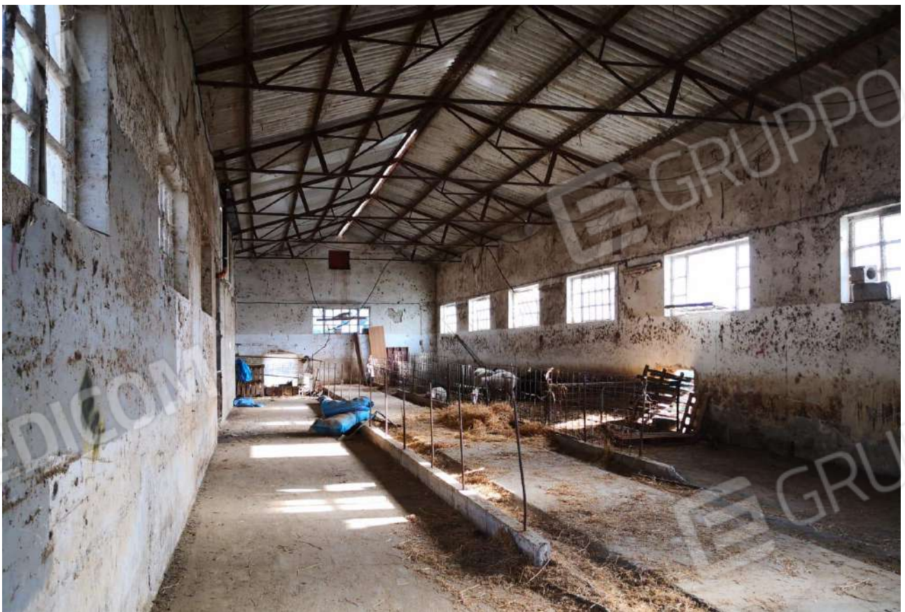
Fotogramma 42 – Fabbricati pertinenziali – In Catasto p.lla 576 – Stalla interno
