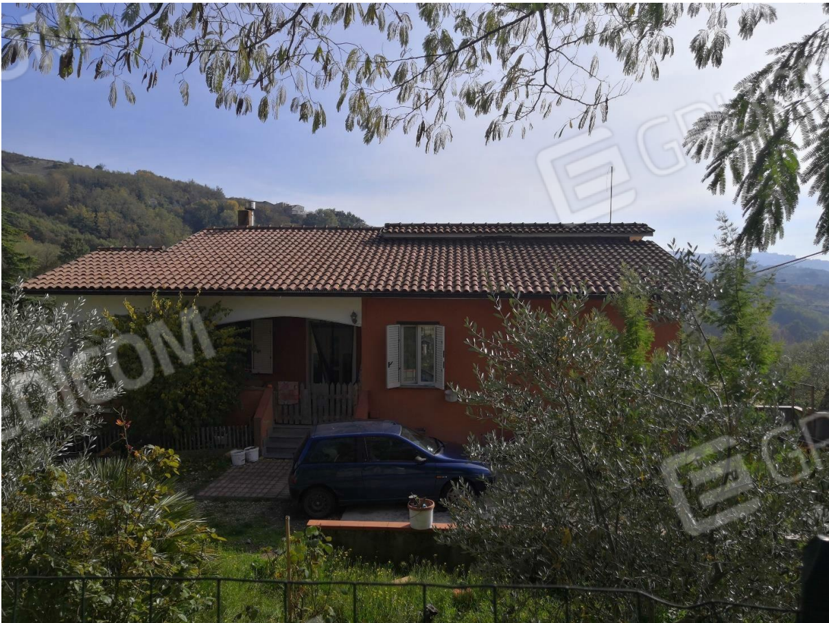
PROSPETTO PRINCIPALE EDIFICIO
