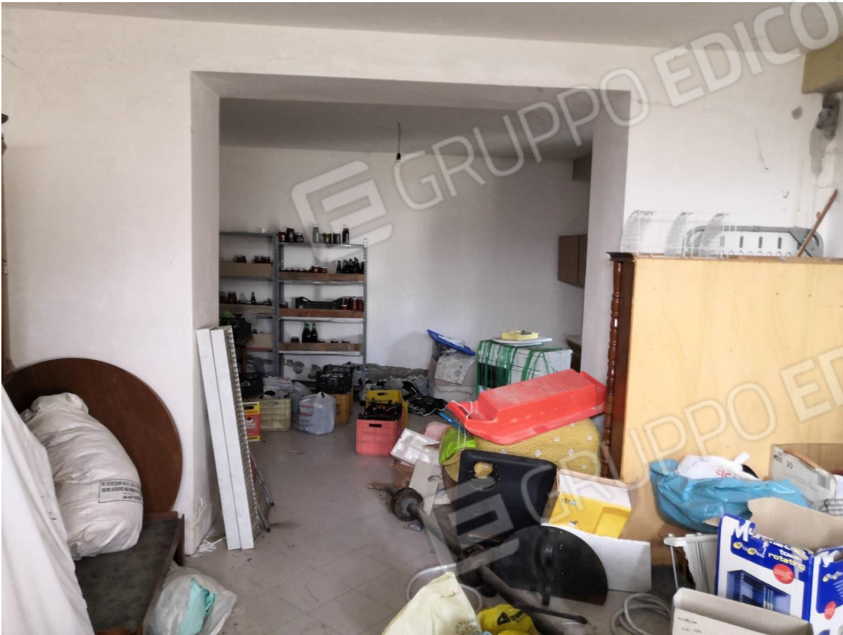
VISTA INTERNO CON COLLEGAMENTO TRA IL SUBALTERNO 3 ED IL SUBALTERNO 2
